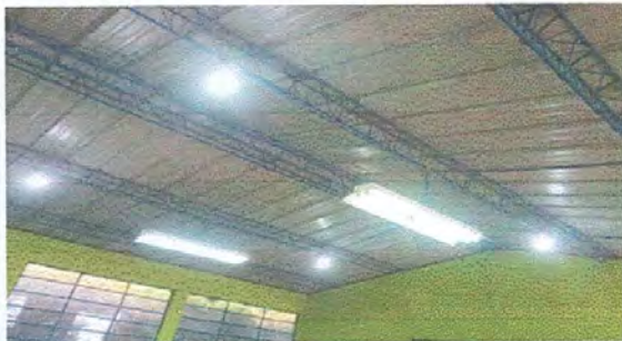
Foto 5: Reparacion del sistema electrica
