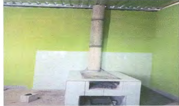
Foto 2: Reparacion de cocina
