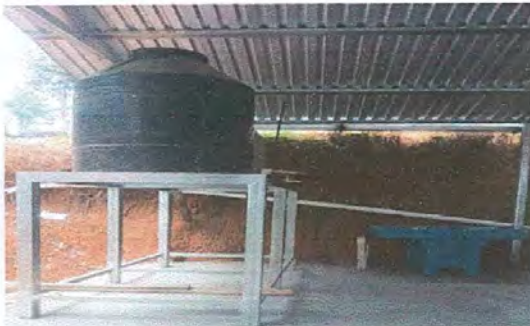
Foto 3: sustitucion de las bases de tiancos
