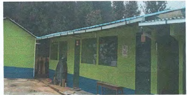
Foto 6: aplicacion de pintura
