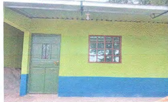
Foto 2: sustitucion de puerta
