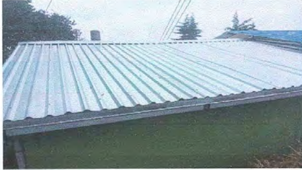
Foto1: Sustitucion de lamina
