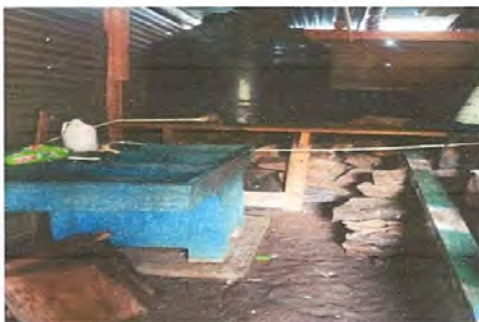
REPARACION BASE DE DEPOSITOS DE ALMACENAMIENTO DE AGUA.
