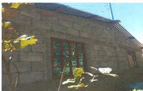
SUSTITUCION DE ESTRUCTURA DE METAL DE VENTANAS
