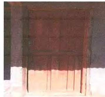
SUSTITUCION DE PUERTA METALICA
