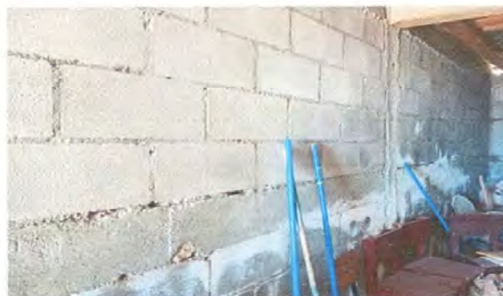
REPARACION DE REPELLO Y CERCIDO DE PAREDES.
