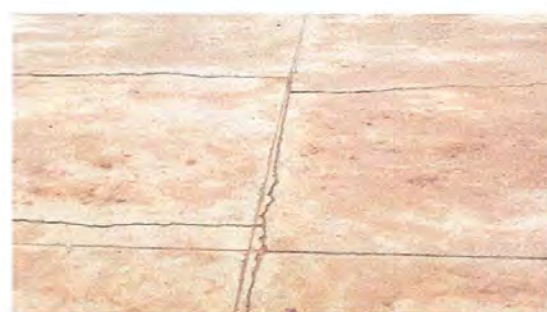
SUSTITUCION DE PISO DE TORTA DE CONCRETO.
