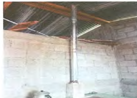
REPARACION DE COCINA , SUSTITUCION DE CHIMENEA DE CONCRETO.
