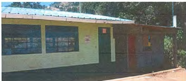
SUSTITUCION DE CANAL DE PVC
