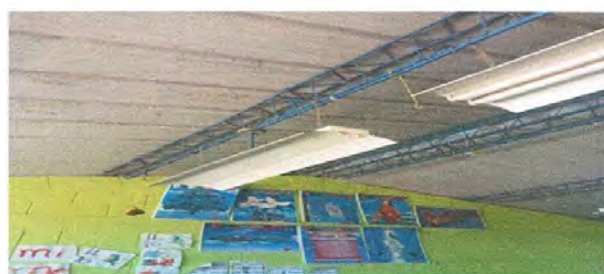
REPARACION DEL SISTEMA ELECTRICO.
