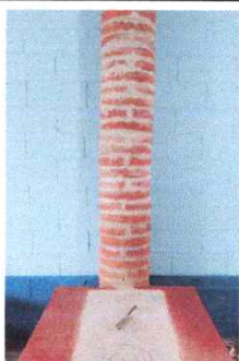
Foto 23: Sustrucción de una segunda estufa rural (completa) incluye chimenea y plancha de metal (con el sobrante del aula 1 no se trabajó porque una pared era de adobe)
