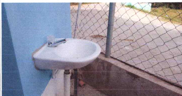
Foto 13: Sustrucción de lavamanos de concreto por lavamanos individuales
