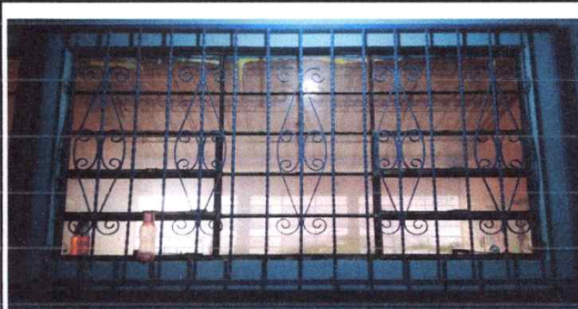
Foto 12: Mejoramiento de balcones de las ventanas de la dirección
