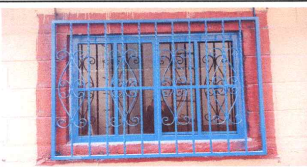
Foto 11: Sustitución de ventana del aula 2
