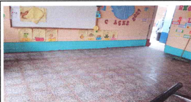
Foto 3: Sustitución de piso de granito del aula 4
