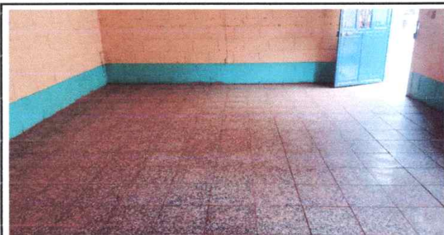
Foto 5: Sustitución de piso de granito del aula 2
