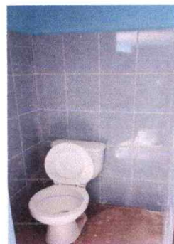
Foto 8: Sustitución de servicios sanitarios y sus accesorios
