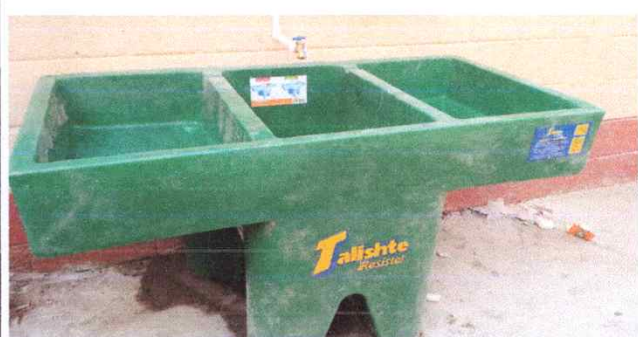
Foto 14: Sustrucción de pila plástica de dos lavaderos
