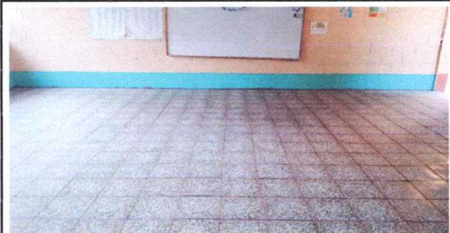
Foto 4: Sustitución de piso del aula 3
