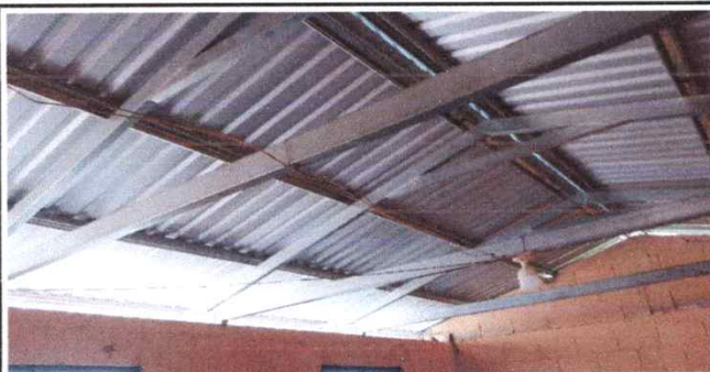
Foto 1: Sustitución de estructura de techo del aula 2
