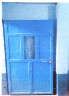
Foto 19: Sustrucción de puerta de madera por metal de la dirección y pintura
