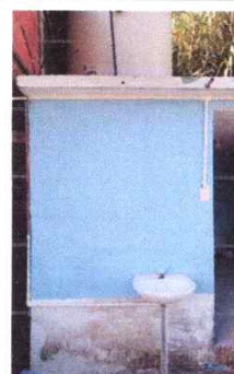
Foto 22: Sustrucción de red de drenajes y red de agua potable
