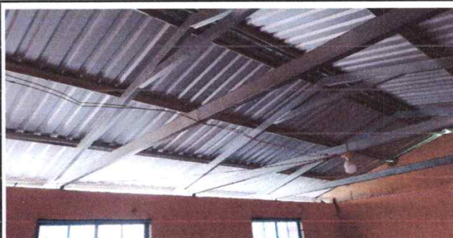
Foto 2: Sustitución de lámina por lámina aluzinc calibre 26 del aula 2
