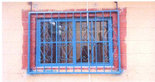
Foto 7: Mejoramiento de balcón de ventana del aula 2
