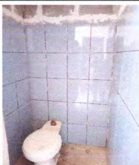
Foto 15: Mejoramiento de azulejo en interior de los sanitarios
