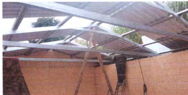
Foto 2: Sustrucción de lámina por lámina aluzinc calibre 26 del aula 2
