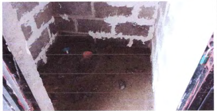
Foto 8: Sustitución de servicios sanitarios y sus accesorios
