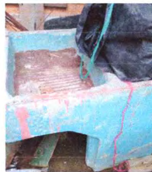
Foto 14: Sustrucción de pila plástica de dos lavaderos
