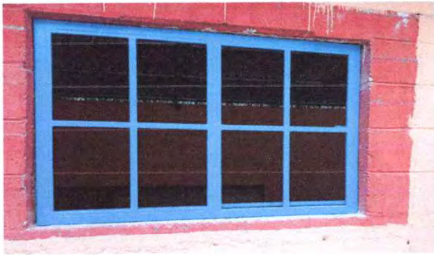
Foto 7: Mejoramiento de balcón de ventana del aula 2
