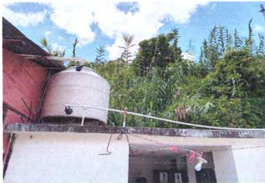
Foto 9: Sustitución de depósito de agua de 1100 lt
