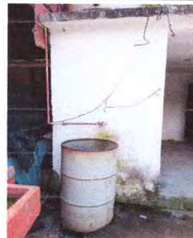
Foto 22: Sustrucción de red de drenajes y red de agua potable
