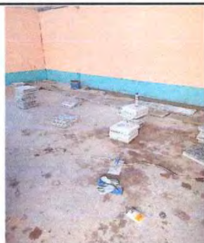
Foto 5: Sustrucción de piso de granito del aula 2
