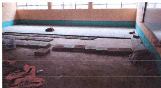
Foto 4: Sustrucción de piso del aula 3
