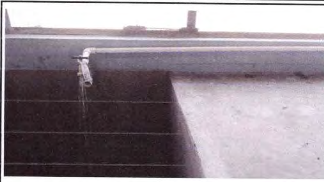
Foto 26: Reparación de la red de agua potable de la cocina (con el sobrante del aula 1 que no se trabajó porque una pared era de adobe)
