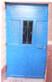
Foto 19: Sustrucción de puerta de madera por metal de la dirección y pintura
