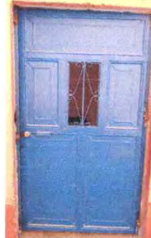
Foto 20: Sustrucción de puerta de madera por metal del aula 2
