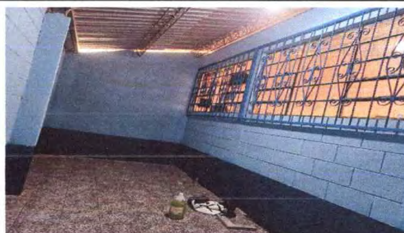
Foto 16: Sustrucción de piso y balcón de ventana de la dirección
