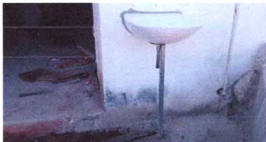
Foto 13: Sustrucción de lavamanos de concreto por lavamanos individuales
