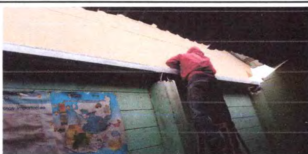
Foto 17: Sustrucción de estructura de techo de la dirección
