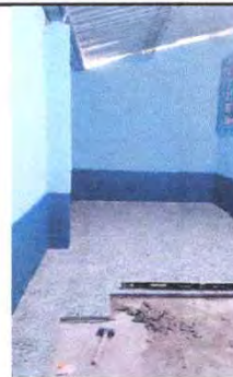
Foto 6: Sustrucción de piso de granito de la dirección
