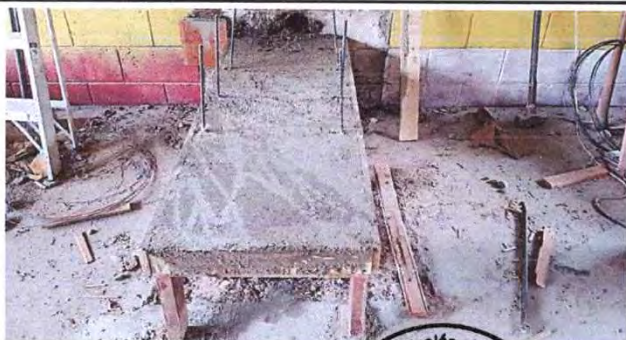
Foto 23: Sustrucción de una segunda estufa rural (completa incluye chimenea y plancha de metal (con el sobrante del aula 1 que no se trabajó porque una pared era de adobe)
