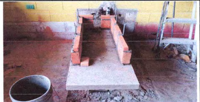
Foto 10: Sustitución de estufa rural (completa) incluye chimenea y plancha de metal
