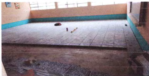
Foto 3: Sustrucción de piso de granito del aula 4
