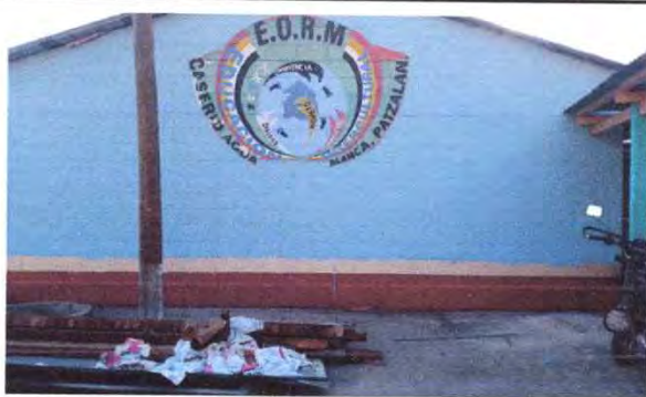
Foto 25: Pintado exterior de la cocina (con el sobrante del aula 1 que no se trabajó porque una pared era de adobe)
