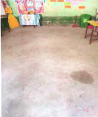
Foto 7: Sustitución de piso de aula 2
