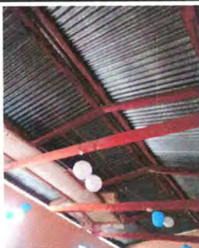
Foto 3: Sustitución de estructura de aula 1
