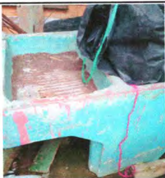
Foto 17: Sustitución de pila plástica de dos lavaderos
