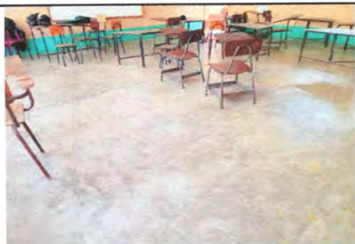
Foto 5: Sustitución de piso de aula 4
