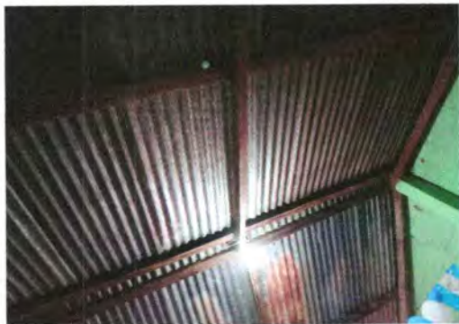
Foto1: Sustitución de techo de aula 1
