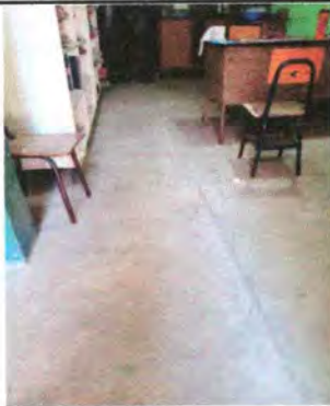
Foto 9: Sustitución de piso de Dirección
