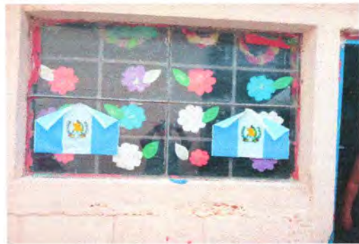
Foto 10: Mejoramiento de balcón de ventana de aula 2
