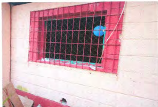
Foto 19: Sustitución de ventana de aula 1
