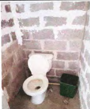
Foto 11: Sustitución de servicios sanitarios y sus accesorios
