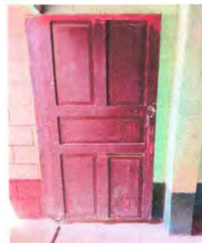
Foto 24: Sustitución de puerta de Dirección y pintura
