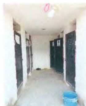
Foto 20: Mejoramiento de azulejo
