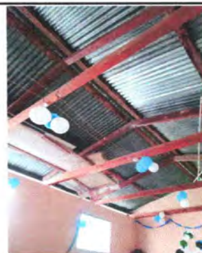
Foto 4: Sustitución de estructura de aula 2
