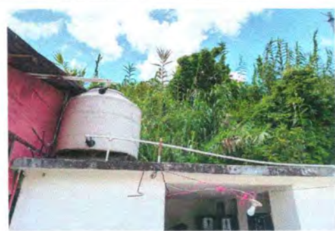
Foto 12: Sustitución de depósito de agua
