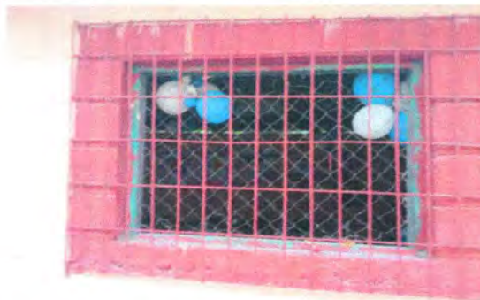
Foto 14: Sustitución de ventana 2
