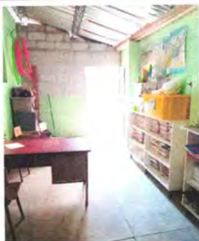
Foto 23: Sustitución de cubierta de lámina de Dirección
