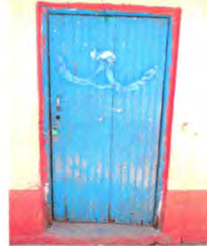
Foto 26: Sustitución de puerta de aula 1
