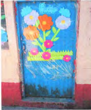
Foto 25: Sustitución de puerta de aula 2
