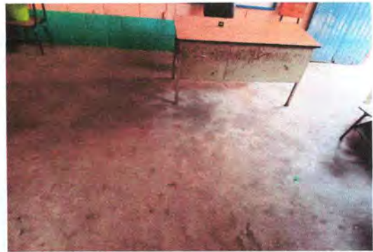
Foto 8: Sustitución de piso de aula 1
