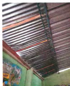
Foto 22: Sustitución de estructura de techo de Dirección
