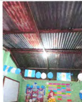
Foto 2: Sustitución de techo de aula 2
