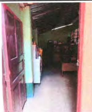
Foto 21: Sustitución de piso y ventana de dirección
