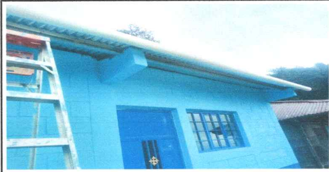
Foto 6: CONCLUYENDO CON LA PUESTA DE CANAL PARA EL AGUA PLUVIAL
