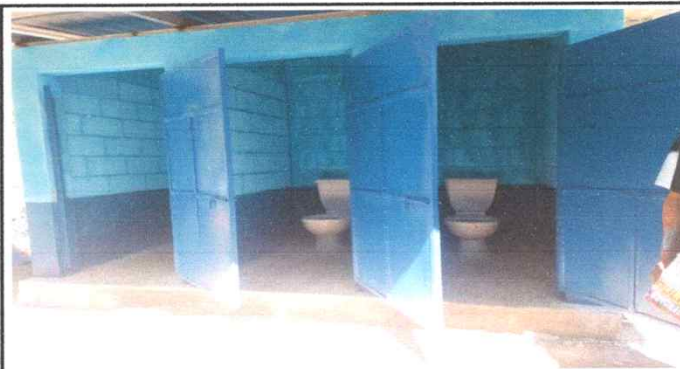
Foto 4: CONCLUYENDO CON EL CAMBIO DE PUERTAS Y EL CAMBIO DE TAZAS DE BAÑO TIPO INODOROS
