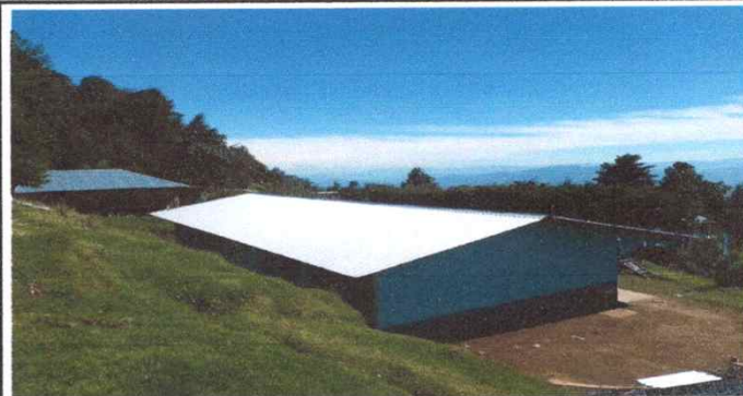
Foto 2: CONCLUYENDO EL CAMBIO DE LAMINAS VIEJAS POR LAMINAS TROQUELADAS EN EL TECHADO DE LAS AULAS
