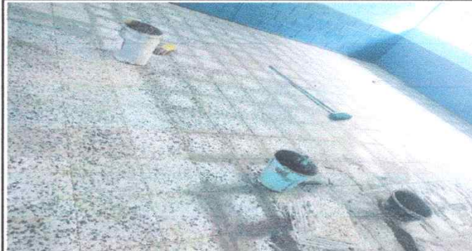
Foto 8: FINALIZACION DE LA PUESTA DE PISO DE GRANITO EN EL AULA DE LA ESCUELA.
