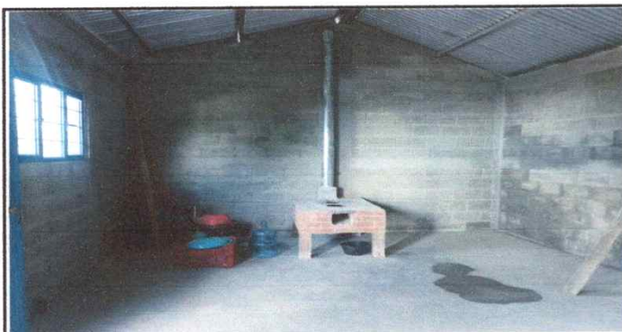
Foto 3: CONCLUYENDO CON LA PUESTA DE PLANCHA METALICA DE COCINA RURAL CON CHIMENEA DE METAL
