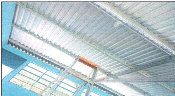
Foto 9 : FINALIZACION DE LA CONEXIÓN DEL SISTEMA ELECTRICO EN LA ESCUELA
