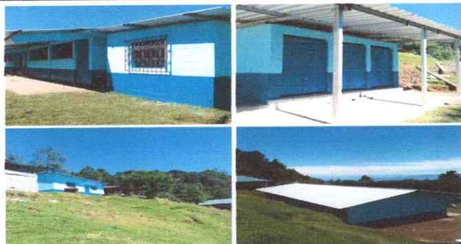
Foto1: CONCLUYENDO PINTADO Y TECHADO EN COCINA, BAÑOS, DIRECCION Y AULAS
