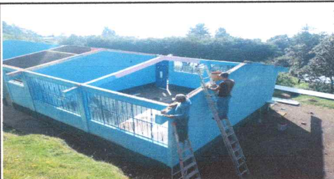
Foto 4: DESMONTAMIENTO DEL TECHADO DE LAS AULAS
