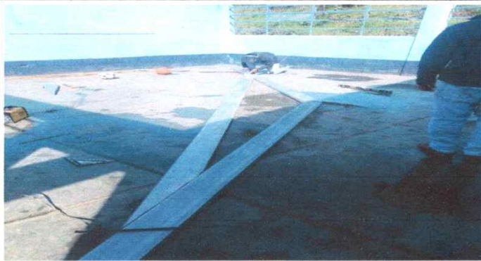
Foto7: EMPEZANDO EN ARMAR LAS ESTRUCTURAS CON TUBOS METALICOS
