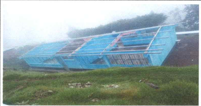
Foto 8: TERMINANDO LA CONSTRUCCION DE LA ESTRUCTURA METALICA EN EN TECHADO DE LAS AULAS BAÑOS Y DIRECCIÓN
