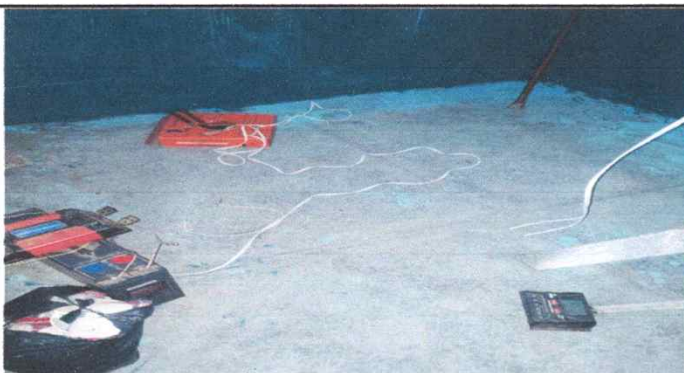
Foto9 : realización de puesta de cables nuevos del sistema electrico de la escuela
