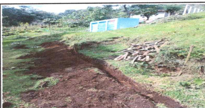
Foto 3: DESMONTAMIENTO DEL TECHADO DE LOS BAÑOS Y ZANJEADO PARA EL DRENAJE DE AGUAS NEGRAS EN LOS SANITARIOS
