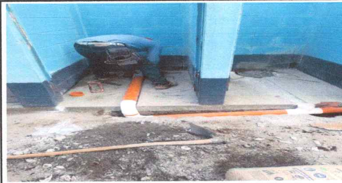
Foto 6: COLOCACIÓN DE LA TUBERIA DE LOS NUEVOS BAÑOS DE TAZA DE BAÑO TIPO INODORO
