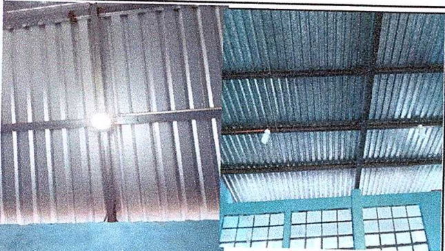
FOTO 7 REPARACION DE SISTEMA ELECTRICO Sustitución de focos en aulas y cocina
