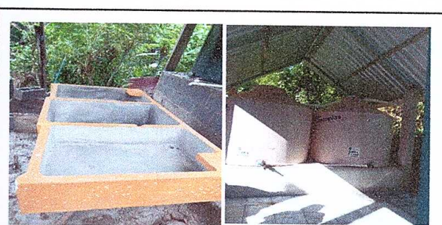
FOTOS 6: Sustrutcion de depósitos de agua de 2,500 litros.
