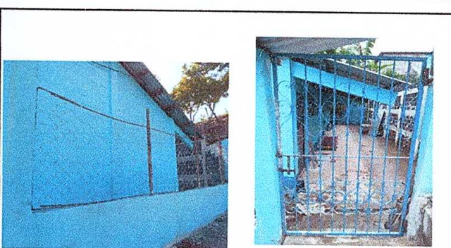
FOTOS 4: Reparación de muro perimetral y sustitución de portón
