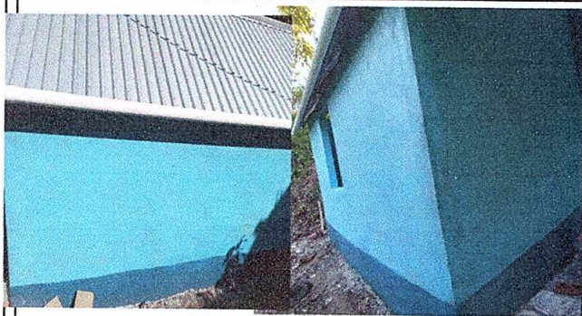
Foto 1: CUBIERTA DE LAMINA. Sustrutcion de láminas por laminas troquelada
