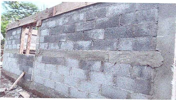
FOTO 3 Mejoramiento de paredes de la cocina
