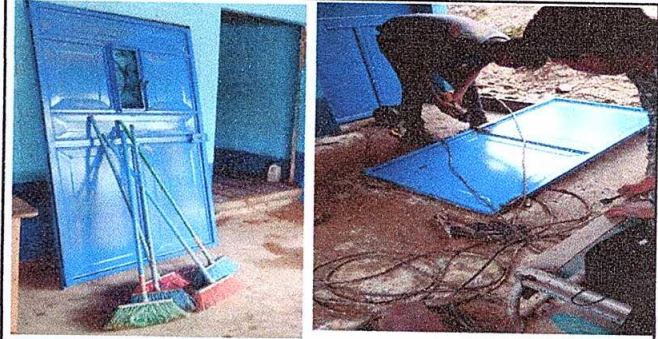
FOTO 2 Sustrucción de cocina y puerta de baños
