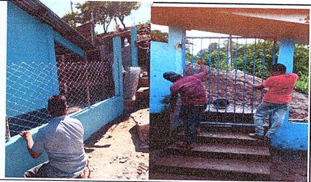
FOTO 4 Reparación de muro perimetral y sustrucción de portón
