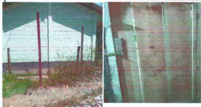
FOTOS 4 Reparación de muro perimetral y sustitución de portón
