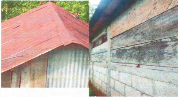
Foto 1: CUBIERTA DE LAMINA. Sustitución de láminas por láminas troquelada
