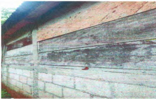
FOTOS 3 Mejoramiento de paredes de la cocina
