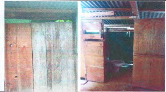
FOTOS 2: Sustitución de cocina y puerta de baños
