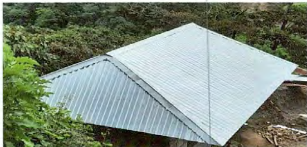
Foto No. 1: Cubierta de lámina finalizada
