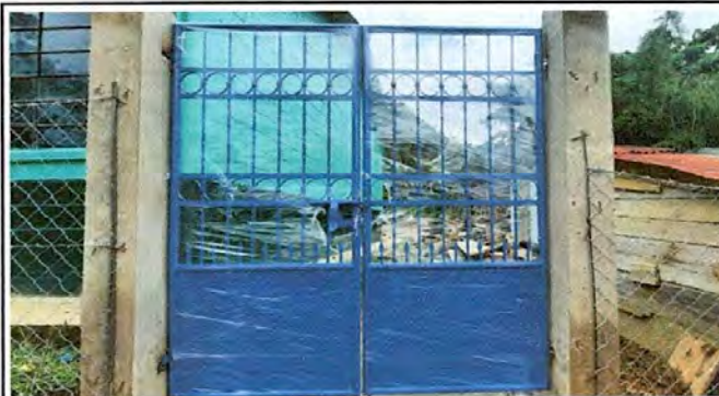
Foto No. 4: Portón de metal instalado
