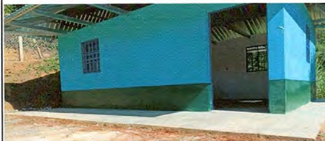
Foto No. 6: Piso de torta de concreto más allsado terminado
