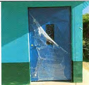
Foto No. 3: Puerta de metal instalada
