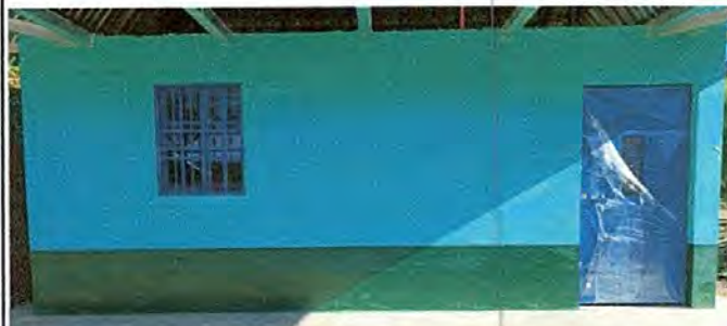
Foto 9: Pared de block con soleras intermedias finalizada
