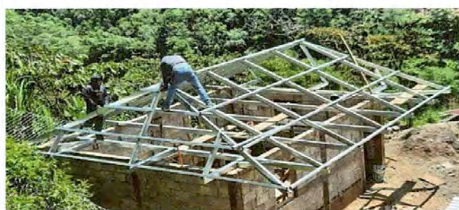
Foto No. 2: Estructura de techo de metal instalado
