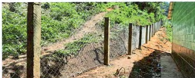
Foto No. 8: Reparación de columna de concreto y sustitución de malla galvanizado finalizado
