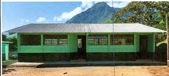
Foto No. 7: Pintura en muros exteriores e interiores finalizado
