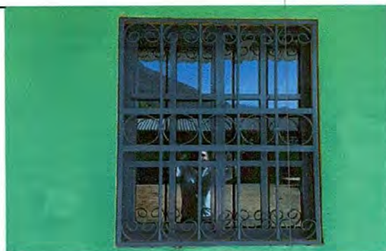
Foto No. 5: Ventanas de metal más vidrio instaladas
