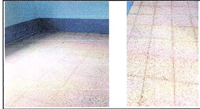
Foto 4: SUSTITUCIÓN DE PISO DE TORTA DE CEMENTO POR PISO DE GRANITO
