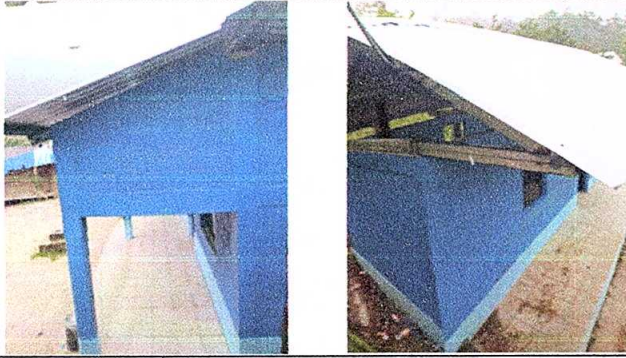
Foto1: SUSTITUCIÓN DE LAMINAS, CAPOTES Y ELEMENTOS DE FIJACION.
