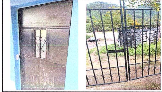
Foto 2: MEJORAMIENTO A ESTRUCTURA DE PUERTA Y SUSTICUCION DE PORTON.
