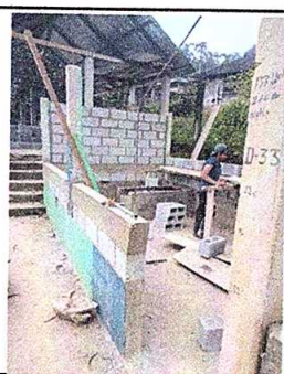
Foto 3: SUSTITUCION DE PLANCHA DE TRES HORNILLAS Y SUSTITUCION DE PARED DE MADERA POR BLOCKS
