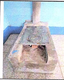
Foto 3: SUSTITUCION DE PLANCHA DE TRES HORNILLAS Y SUSTITUCION DE PARED DE MADERA POR BLOCKS
