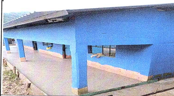
Foto 5: PINTURA INTERIORES Y EXTERIORES
