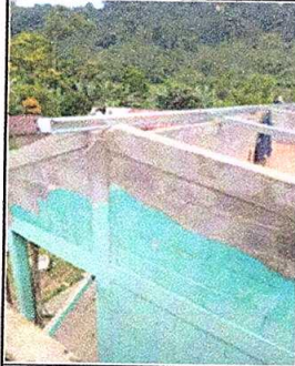
Foto 1: SUSTITUCIÓN DE LAMINAS, CAPOTES Y ELEMENTOS DE FIJACION.
