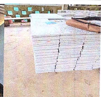
Foto 4: SUSTITUCIÓN DE PISO DE TORTA DE CEMENTO POR PISO DE GRANITO
