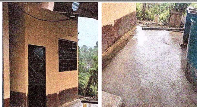
Foto 6: MANTENIMIENTO DE LAS VENTANAS Y PISO DE CONCRETO.
