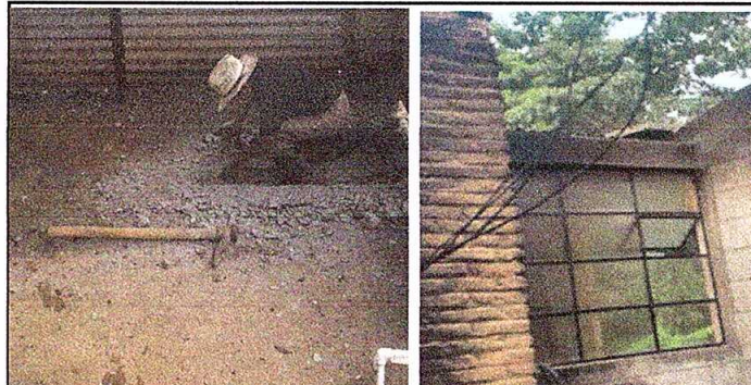
Foto 6: MANTENIMIENTO DE LAS VENTANAS Y PISO DE CONCRETO.
