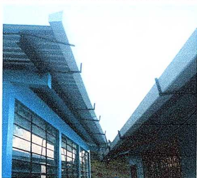
Foto 5: Canales y bajadas de agua pluvial
