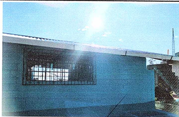
Foto1: Cubierta de lámina
