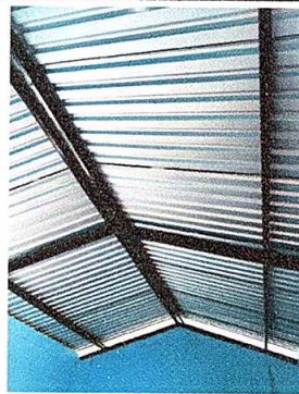
Foto 2: Mantenimiento de estructura de soporte de metal
