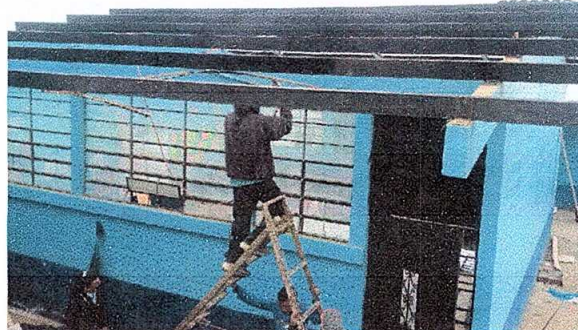
Foto 2: Mantenimiento de estructura de soporte de metal
