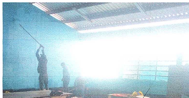
Foto 6: Pintura en muros exteriores e interiores
