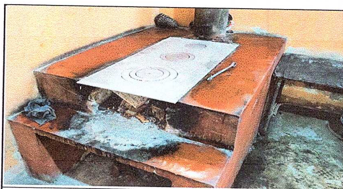
Foto 6: Plancha de metal de 3 hornillas en muy malas condiciones
