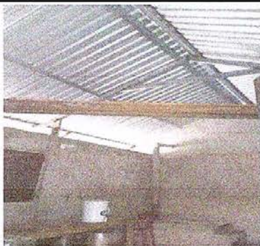
Foto 5: sustitución de costanera de madera de la cocina a costanera metal
