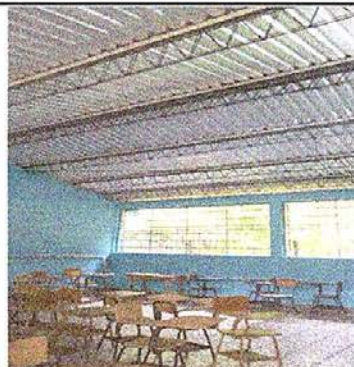
Foto 2: sustitución de de estructura de soporte de metal por metal.
