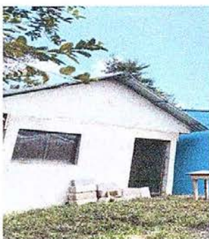
Foto 9: colocamiento de block en los mojinetes de la cocina
