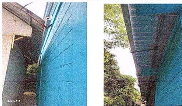
Foto 10: Canal clasico de 6 m. en la escuela y en la cocina
