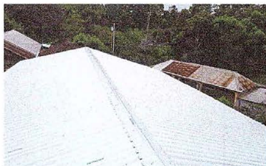
Foto 4: Sustitución de capote de lamina para lámina teoquelada
