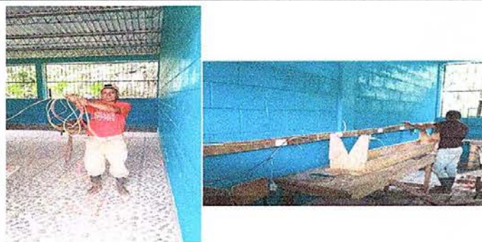
Foto 11: Sustitución de cable THH 100 AWG
