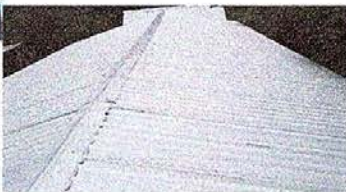
Foto1: Sustitución de lamina por lamina troquelada
