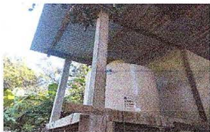
Foto7: sustitución de deposito de agua
