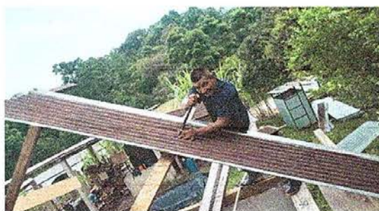
Foto 6: sustitución de lámina de la cocina a láminas troquelada.
