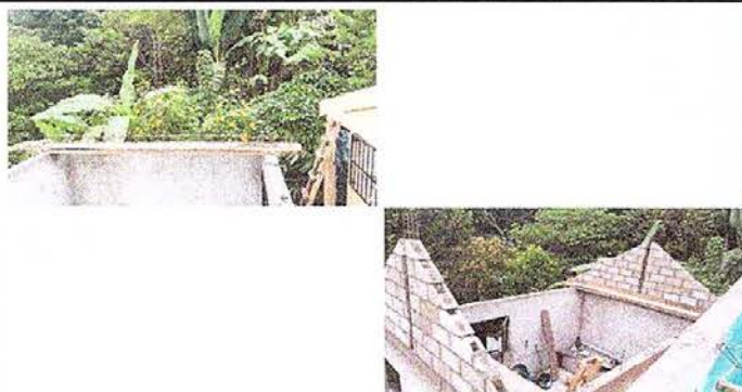
Foto 9: colocamiento de block en los mojinetes de la cocina
