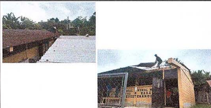
Foto1: Sustitución de lamina por lamina troquelada
