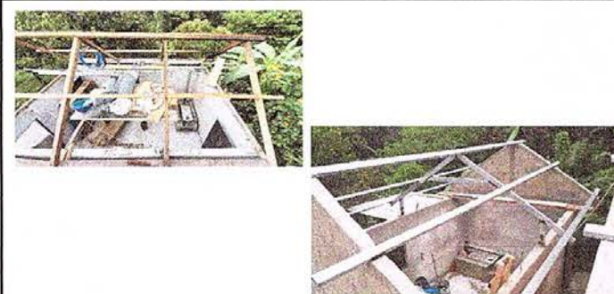
Foto 5: sustitución de costanera de madera de la cocina a costanera metal
