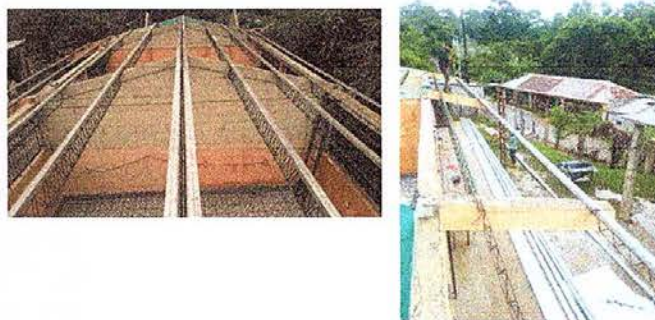
Foto 2: sustitución de de estructura de soporte de metal por metal.
