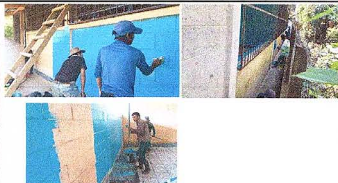
Foto 8: pintura en muros exteriores o interiores
