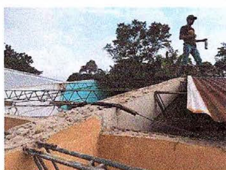
Foto 4: Sustitución de capote de lamina para lámina teoquelada
