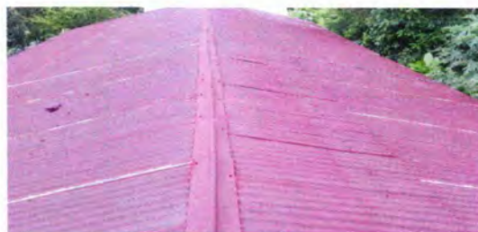
Foto 4: Sustitución de capote de lámina para lámina troquelada
