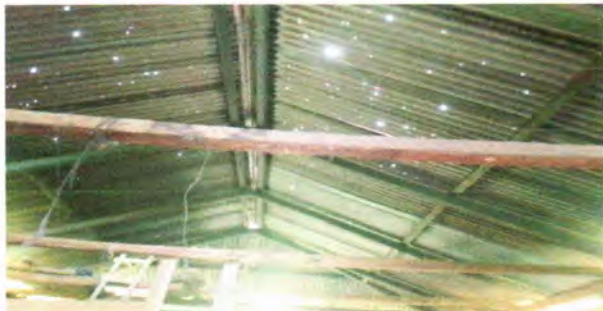
Foto 5: Sustitución de costanera madera de la cocina a costanera metal.
