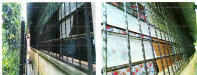
Foto 3: sustitución de ventanas de metal
