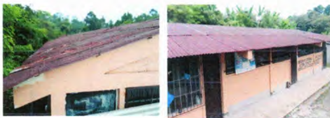
Foto 1: sustitución de lámina por lámina troquelada.
