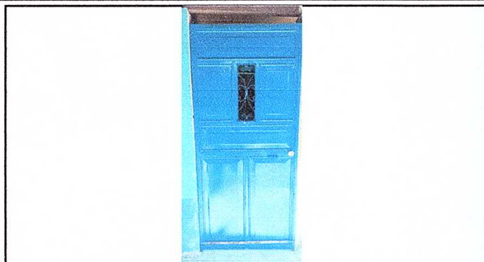
Foto 1: Sustitución de puertas de madera a metal.
