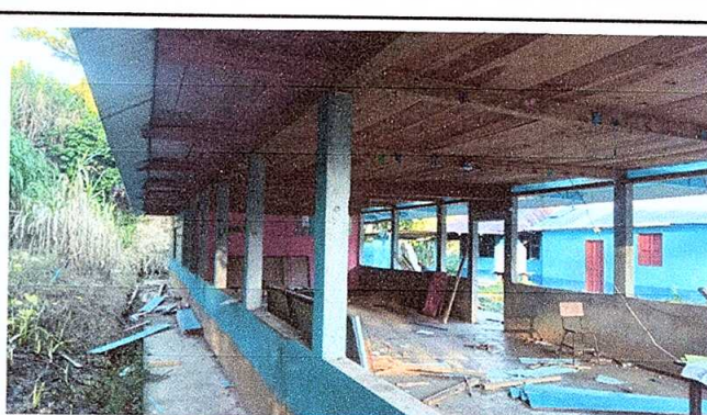
Foto 4: Sustrucción de paredes de madera por block en aulas.
