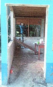
Foto 1: Sustrucción de puertas de madera a metal.
