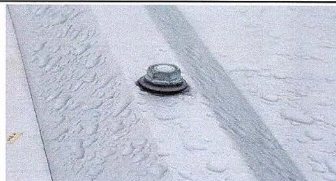
Foto 3: Sustitución de elementos de fijación
