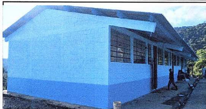
Foto 7: pintura en pared exterior
