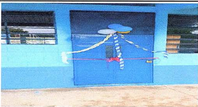
Foto 5: Sustitución de puertas 2.95 x 1.35 metros
