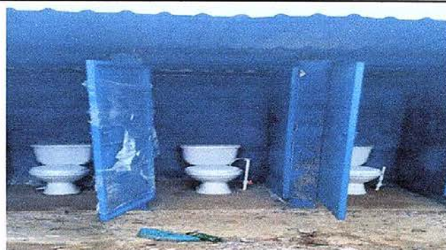
Foto 10: Sustitución de inodoro
