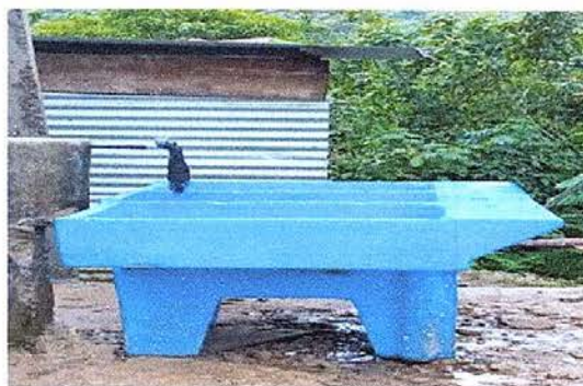
Foto 8: sustitución de pila de cemento de dos lavaderos
