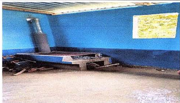
Foto 9: Sustitución de pared de madera por block en cocina
