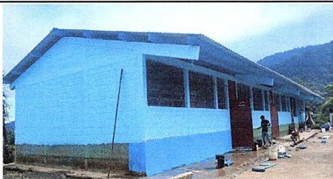
Foto 7: pintura en pared exterior
