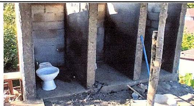
Foto 10: Sustitución de inodoro
