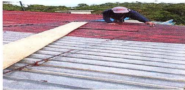
Foto 3: Sustitución de elementos de fijación
