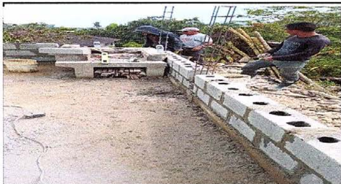
Foto 9: Sustitución de pared de madera por block en cocina
