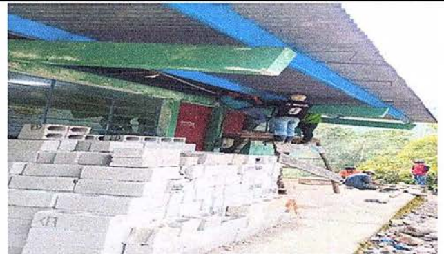
Foto 4: Mantenimiento a estructura de soporte de metal
