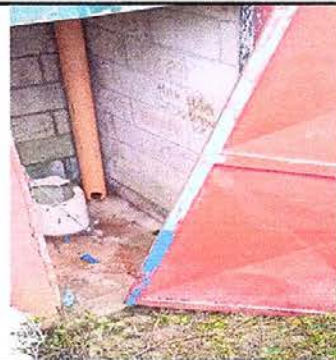
Foto 6: Sustitución de puerta en servicios sanitarios 1.85 x 0.81 metros
