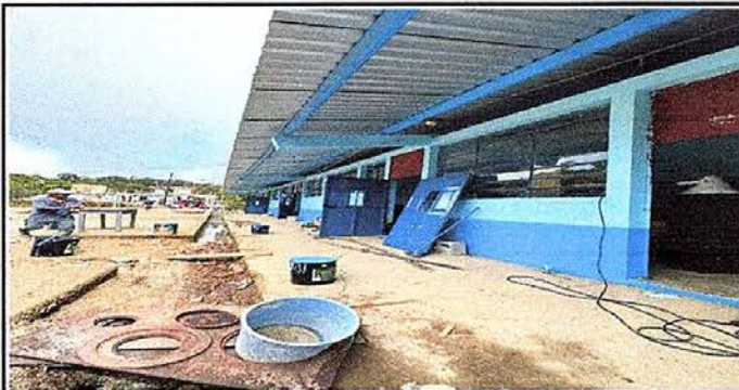
Foto 5: Sustitución de puertas 2.95 x 1.35 metros
