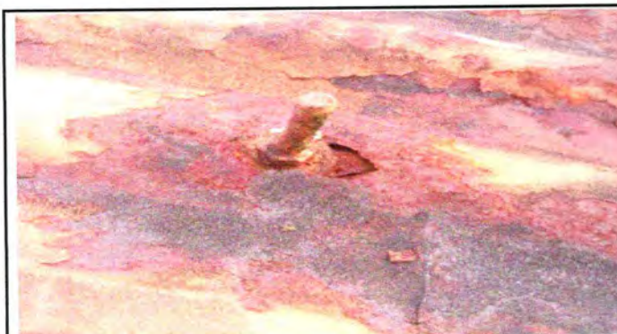
Foto 3: Sustitución de elementos de fijación
