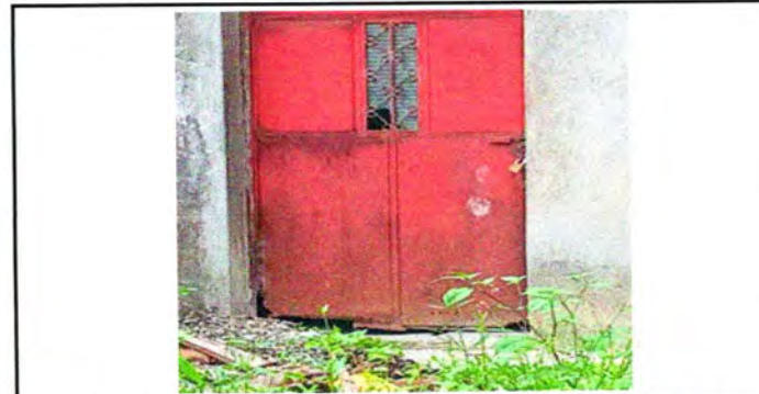
Foto 6: Sustitución de puerta en servicios sanitarios 1.85 x 0.81 metros
