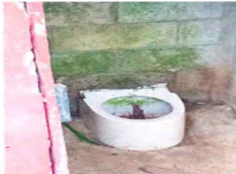
Foto 10: Sustitución de inodoro
