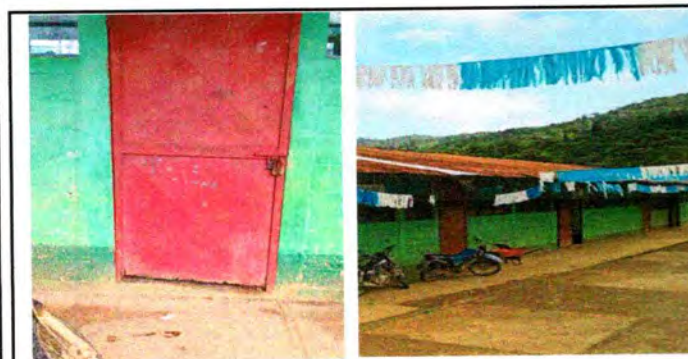
Foto 5: Sustitución de puertas 2.95 x 1.35 metros
