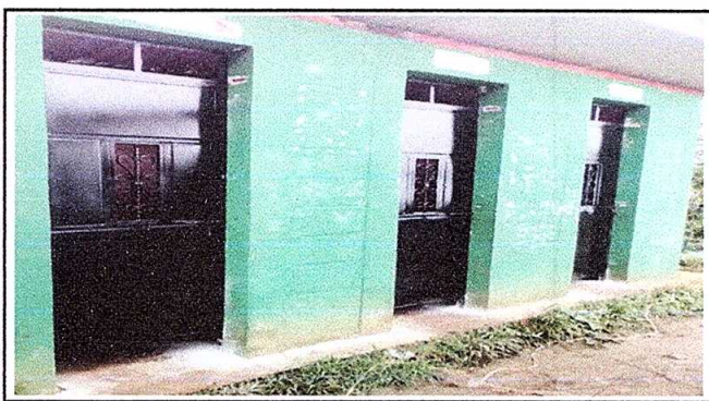
Foto 4: sustitución de puertas en servicios sanitarios
