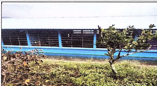
Foto 1: sustitución de lámina por lámina troquelada.
