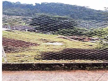
Foto 8: reparación de tubo hg y malla galvanizada.
