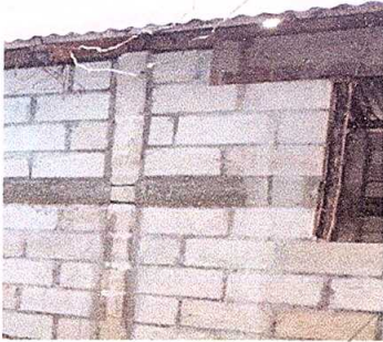
Foto 7: sustitución de pared de madera a block.
