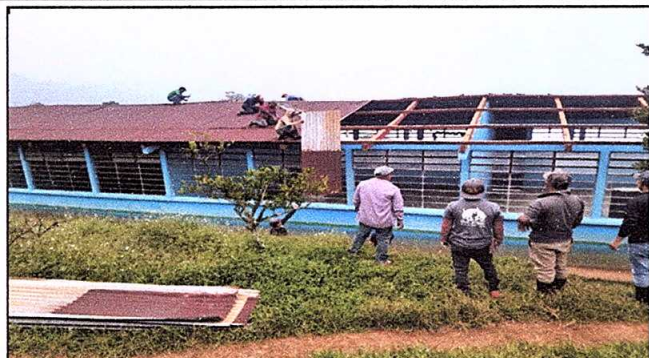
Foto 1: sustitución de lámina por lámina troquelada.
