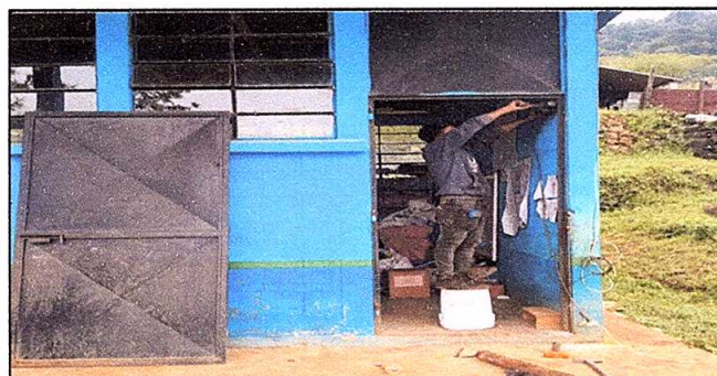
Foto 5: sustitución de puertas.
