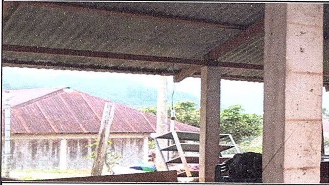
Foto 7: sustitución de pared de madera a block.
