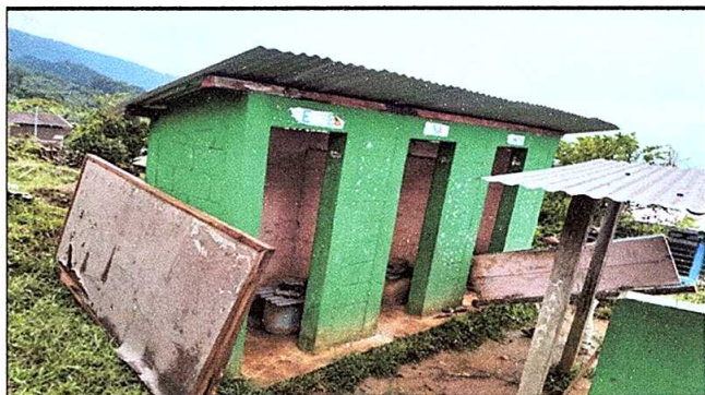
Foto 4: sustitución de puertas en servicios sanitarios
