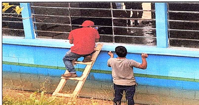
Foto 6: sustitución de vidrios.
