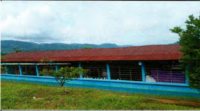
Foto 1: sustitución de lámina por lámina troquelada.
