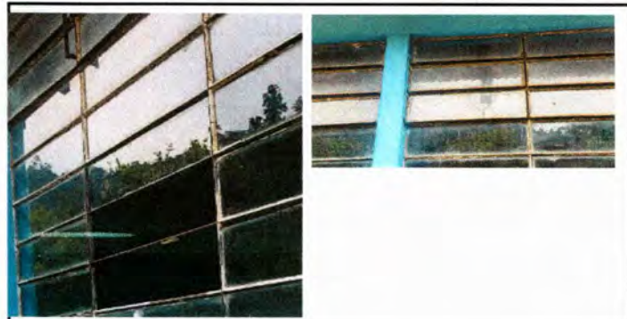
Foto 6: sustitución de vidrios.
