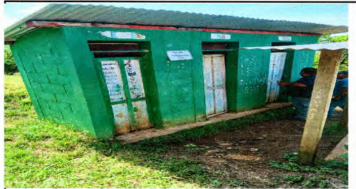
Foto 4: sustitución de puertas en servicios sanitarios
