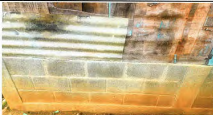
Foto 7: sustitución de pared de madera a block.
