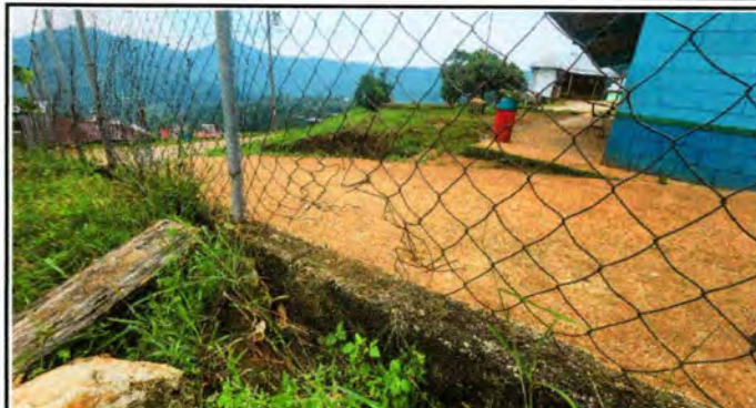
Foto 8: reparación de tubo hg y malla galvanizada.
