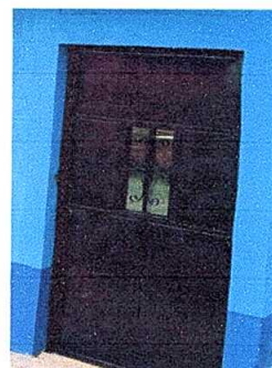
Foto 6: Sustitución de puertas
