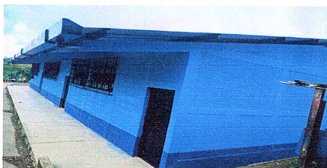
Foto 3: Mejoramiento de ventanas por balcones
