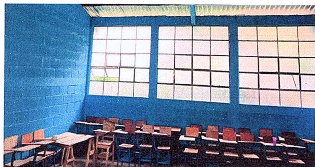
Foto 5: Pintura en muros exteriores e interiores
