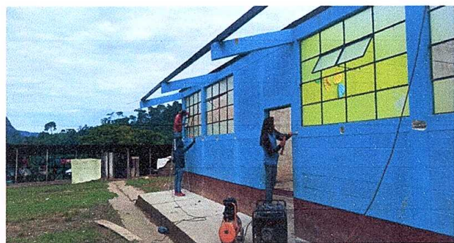
Foto 3: Mejoramiento de ventanas por balcones
