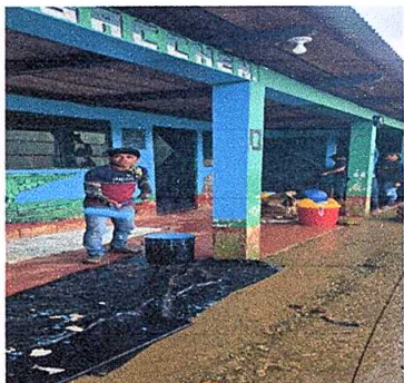
Foto 5: Pintura en muros exteriores e interiores
