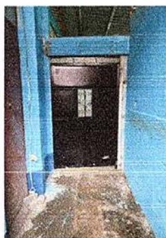
Foto 3: sustitución de puerta.
