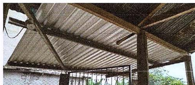
Foto 4: sustitución de estructura de soporte de madera por metal.
