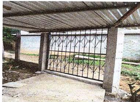
Foto 8: Sustitución de porton de metal de ingreso
