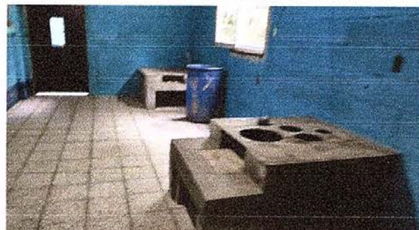
Foto 10: Reparación de cocina.
