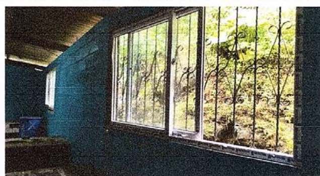
Foto 6: sustitución de ventana de madera por metal mas vidrio.
