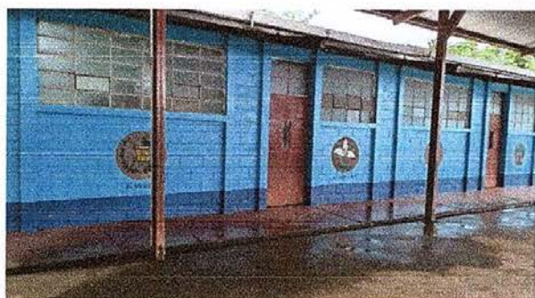
Foto 9: Pintura en muros exteriores e interiores
