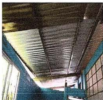
Foto 1: Sustitución de lámina por lámina troquelada.
