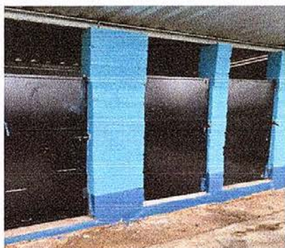
Foto 5: Sustitucion de perta en servicios sanitarios
