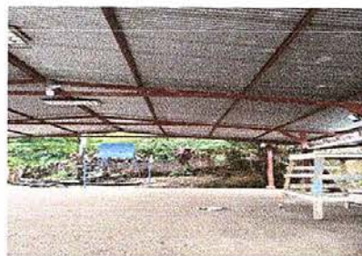
Foto 12: sustitución de lamparas tipo LED
