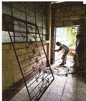
Foto 7: Instalacion de balcones de hierro en ventanas
