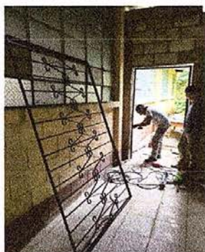
Foto 3: sustitución de puerta.
