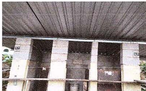
Foto 2: sustitución de elementos de fijación.
