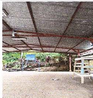
Foto 12: sustitución de lamparas tipo LED
