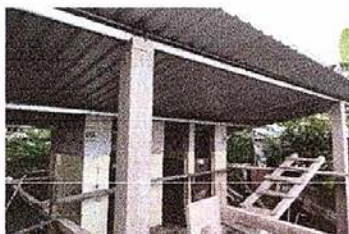
Foto 1: Sustitución de lámina por lámina troquelada.
