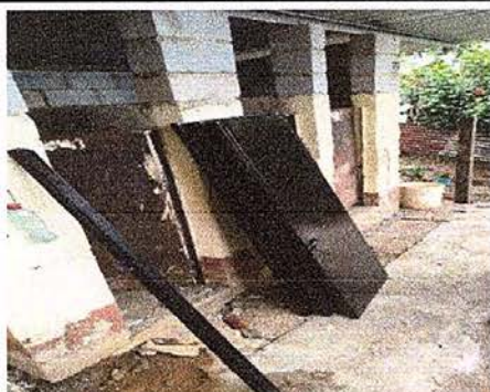
Foto 5: Sustitución de puertas en servicios sanitarios.
