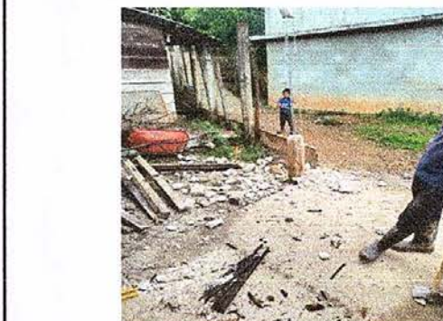
Foto 8: Sustitución de porton de metal de ingreso
