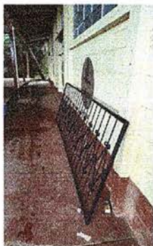
Foto 7: Instalacion de balcones de hierro en ventanas
