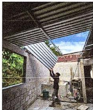
Foto 1: Sustitución de lámina por lámina troquelada.
