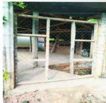
Foto 8: sustitución de porton de metal de ingreso
