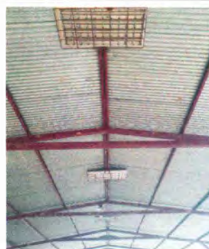
Foto 12: sustitución de lamparas tipo LED
