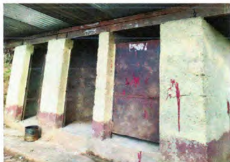
Foto 5: Sustitucion de puerta de servicios sanitarios.
