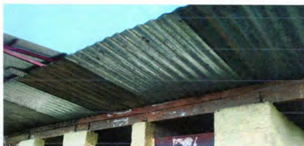
Foto 4: sustitución de estructura de soporte de madera por metal.
