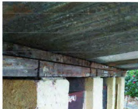
Foto 2: sustitución de elementos de fijación.
