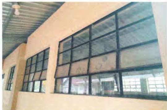
Foto 7: Mejoramiento de balcones de hierro en ventana.
