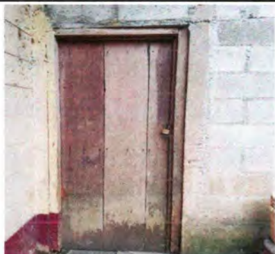
Foto 3: sustitución de elementos de fijación.
