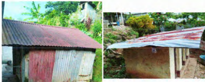
Foto 1: sustitución de lámina por lámina troquelada.
