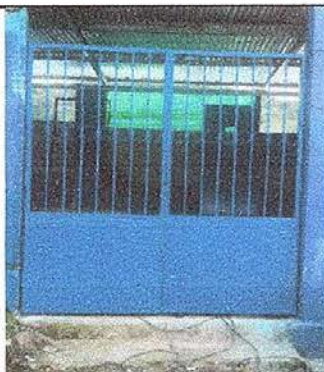
Foto 13: sustitución de portón de metal
