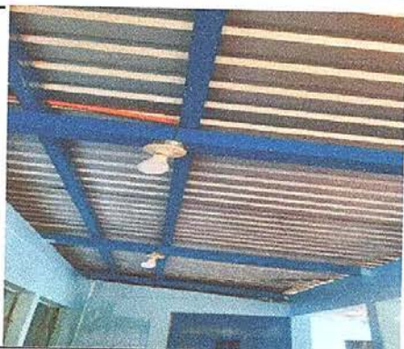
Foto 9: reparación de cableado eléctrico, focos ahorradores y plafoneras.
