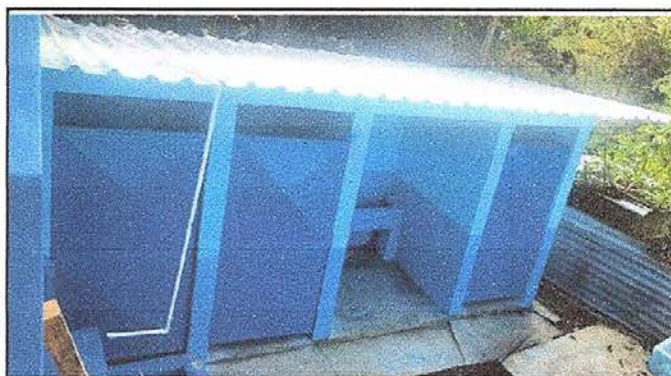
Foto 4: Sustitución de puertas en servicios sanitarios
