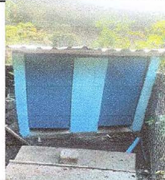
Foto 12: Sustitucion de puerta de servicio sanitario 2
