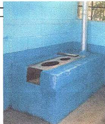
Foto 16: Sustitución de estufa rural (completa) incluye chimenea y plancha de metal
