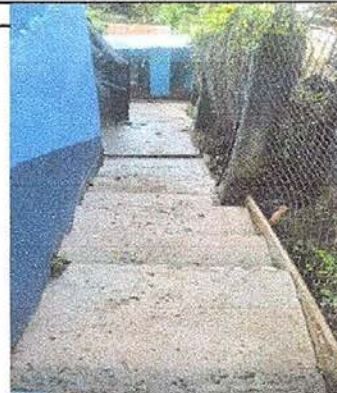
Foto 14: Sustitucion de piso de torta de concreto.
