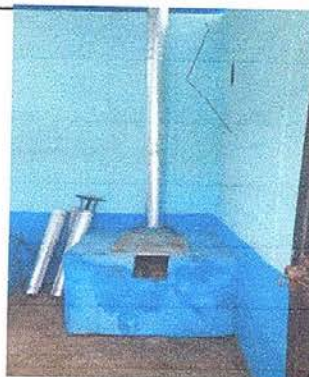
Foto 10: Sustitución de plancha de metal de 3 hornillas
