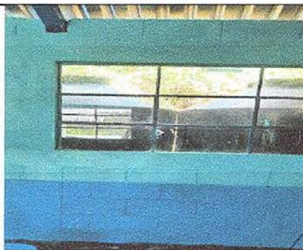
Foto 6: pinturas en muros exteriores e interiores
