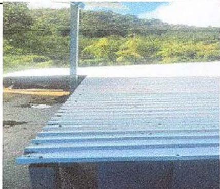
Foto1: sustitución de lámina, por lámina troquelada Aluzinc 16.
