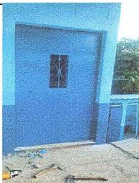
Foto 3: Sustitución de puertas
