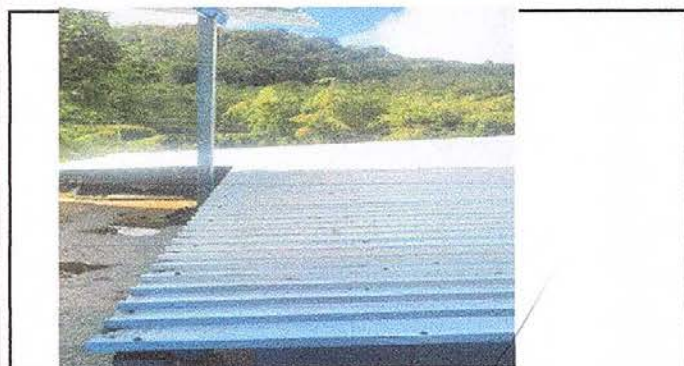
Foto 5: Sustitución de canal de pvc.
