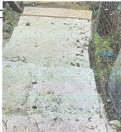
Foto 14: Sustitucion de piso de torta de concreto.
