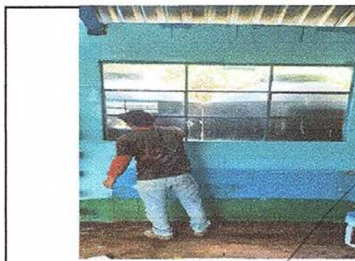
Foto 6: pinturas en muros exteriores e interiores
