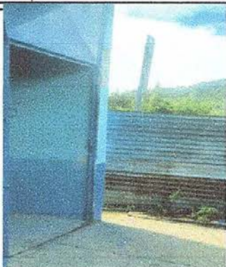
Foto11: sustitución de puerta de otra aula.
