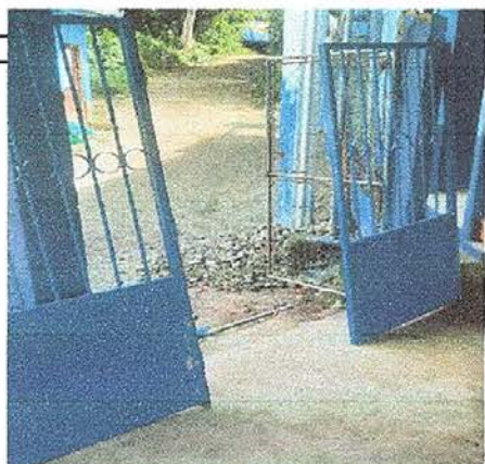
Foto 13: sustitución de portón de metal
