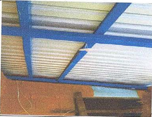
Foto 9: reparación de cableado eléctrico, focos ahorradores y plafoneras.
