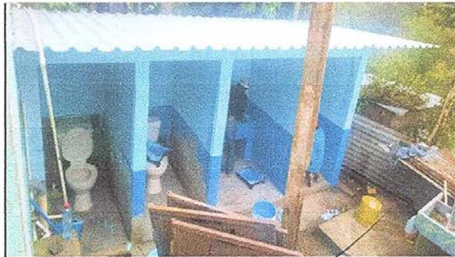
Foto 4: Sustitución de puertas en servicios sanitarios
