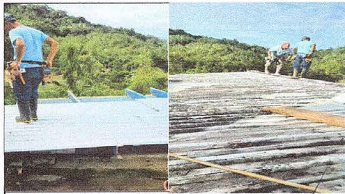
Foto1: sustitución de lámina, por lámina troquelada Aluzinc 16.
