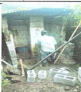
Foto 12: Sustitucion de puerta de servicio sanitario 2
