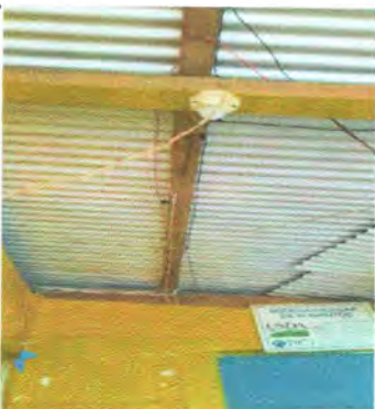
Foto 9: reparación de cableado eléctrico, focos ahorradores y plafoneras.
