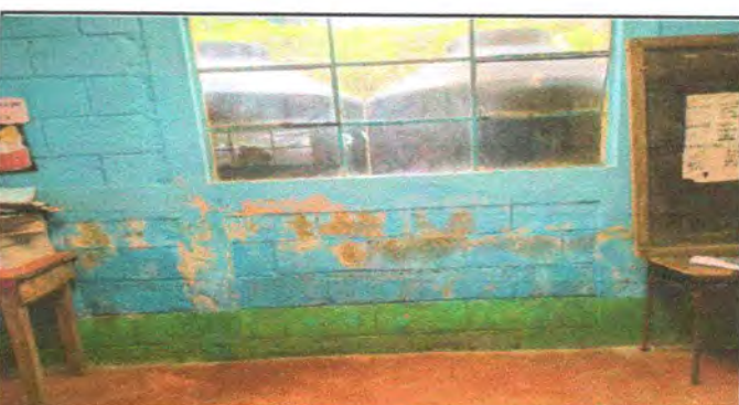
Foto 6: pinturas en muros exteriores e interiores
