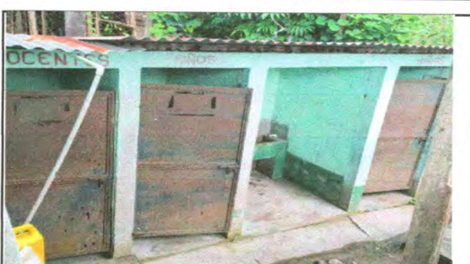
Foto 4: Sustitución de puertas en servicios sanitarios
