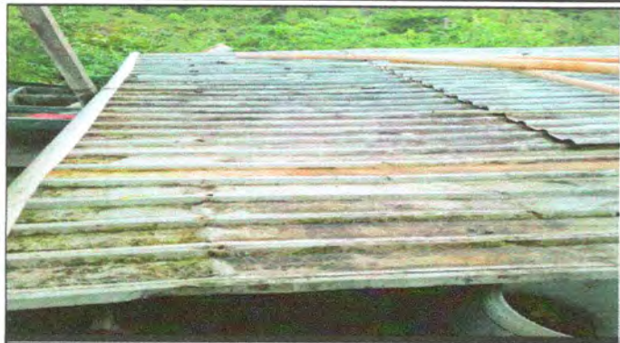
Foto1: sustitución de lámina, por lámina troquelada Aluzinc 16.
