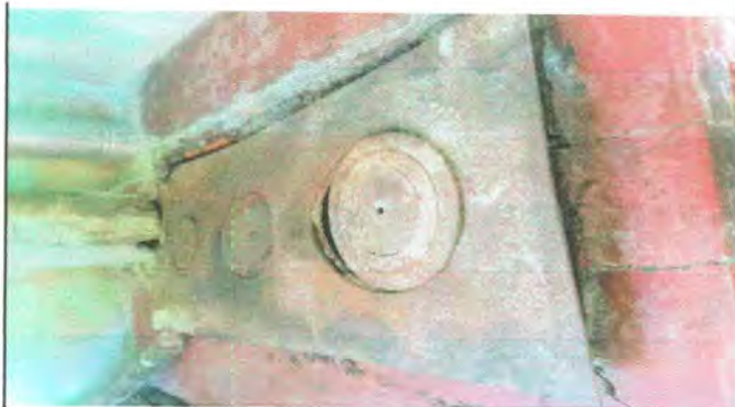
Foto 10: Sustitución de plancha de metal de 3 hornillas
