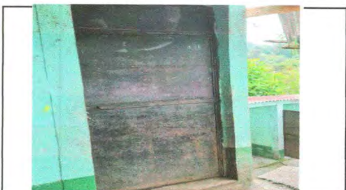
Foto 3: Sustitucion de puertas
