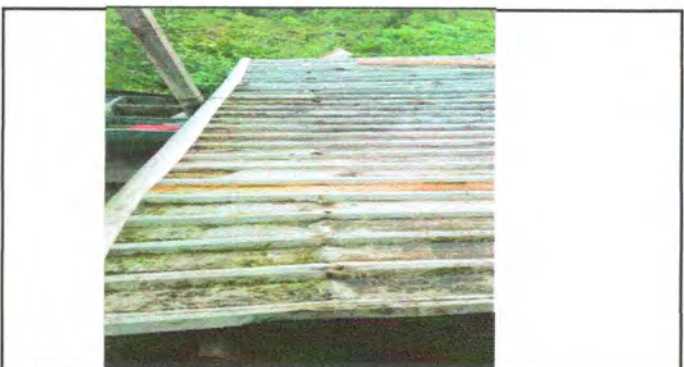
Foto 5: Sustitución de canal de pvc.
