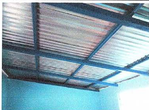
Foto No. 9: Sustitución de vigas de madera por vigas de metal y costaneras.
