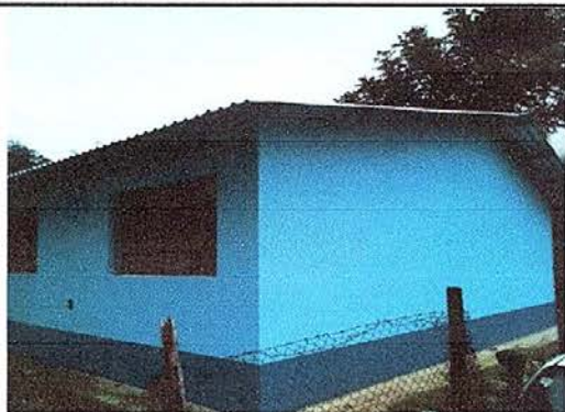
Foto No. 1: Cambio de láminas en mal estado por láminas troqueladas.
