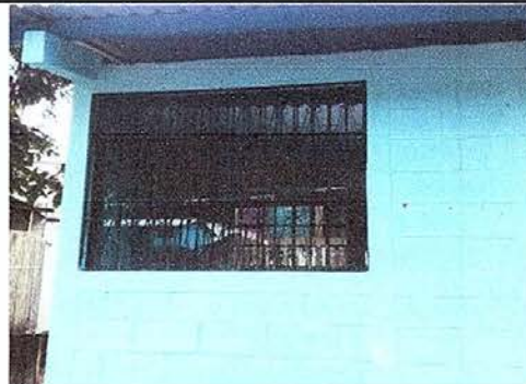
Foto No. 6: Cambio de ventana para cocina.
