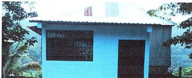
Foto No. 10: Sustitución de láminas por láminas troqueladas.
