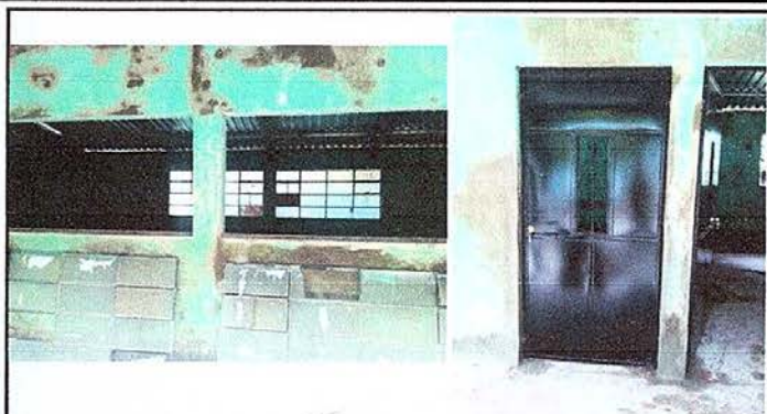
Foto No. 2: Cambio de ventanas y puertas en mal estado.
