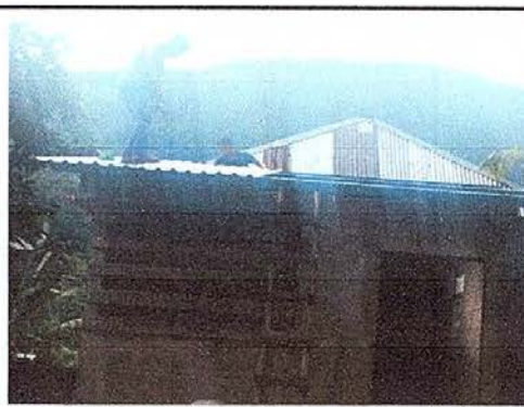
Foto No. 10: Sustitución de láminas por láminas troqueladas.
