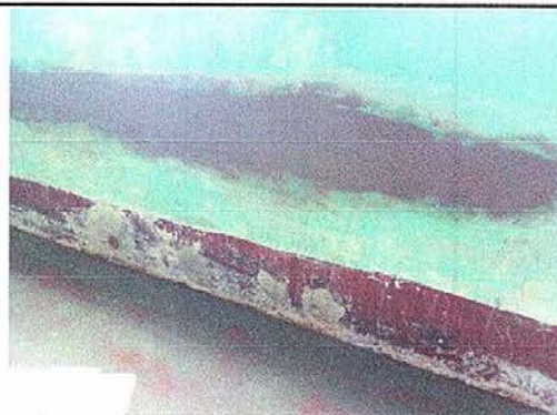
Foto No. 8: Repello de las aulas.
