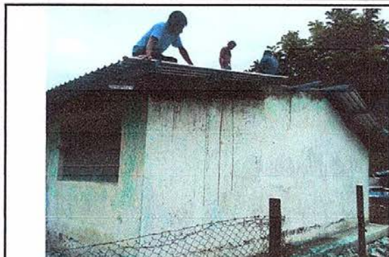
Foto No. 1: Cambio de láminas en mal estado por láminas troqueladas.
