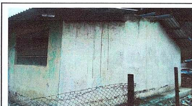
Foto No. 4: Reparación de la pintura en interiores y exteriores.
