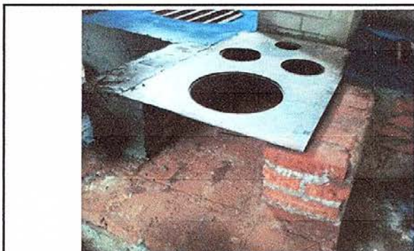
Foto No. 5: Cambio de plancha.
