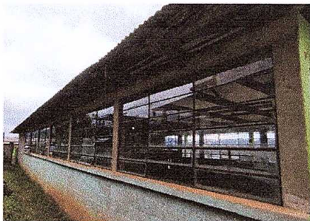
Foto 3: Sustitución de ventanas.
