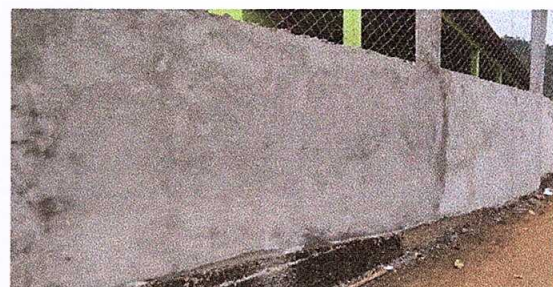
Foto 6: Repello en muro.
