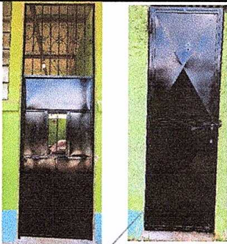
Foto 1: Sustitución de puertas.
