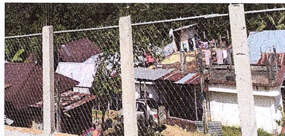
Foto 4: Reparación de muro perimetral de block con tubo hg y malla galvanizada, soleras intermedias y columnas.
