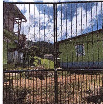
Foto 2: Sustitución de portón de metal.
