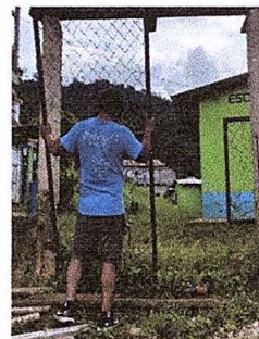
Foto 2: Sustitución de portón de metal.
