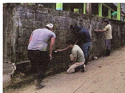
Foto 6: Reparación en muro.
