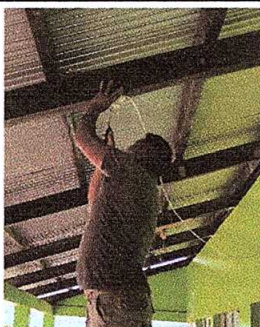
Foto 5: Reparación de sistema eléctrico.
