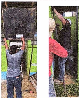
Foto1: Sustitución de puertas.
