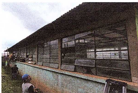
Foto 3: Mantenimiento a estructura de metal de ventanas.
