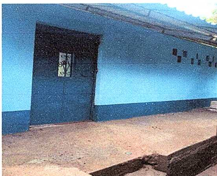
Foto No. 3: Sustitución de puerta.
