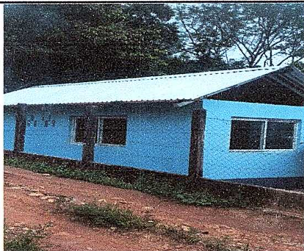
Foto No. 1: Sustitución de láminas en mal estado y techo por laminas nuevas.
