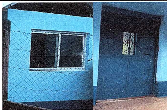
Foto No. 2: Sustitución de puertas y ventanas.
