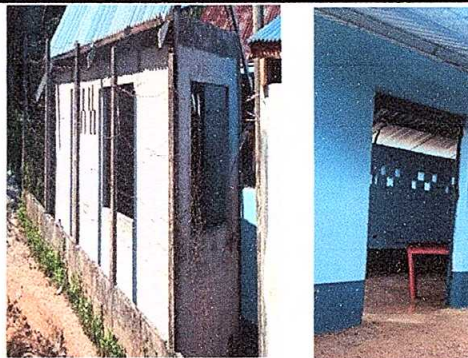
Foto No. 2: Sustitución de puertas y ventanas.
