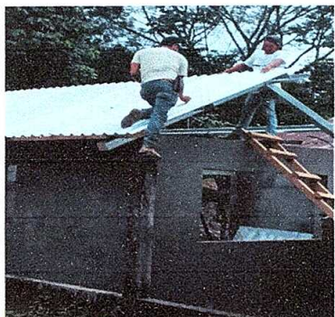
Foto No. 1: Sustitución de láminas en mal estado y techo por laminas.
