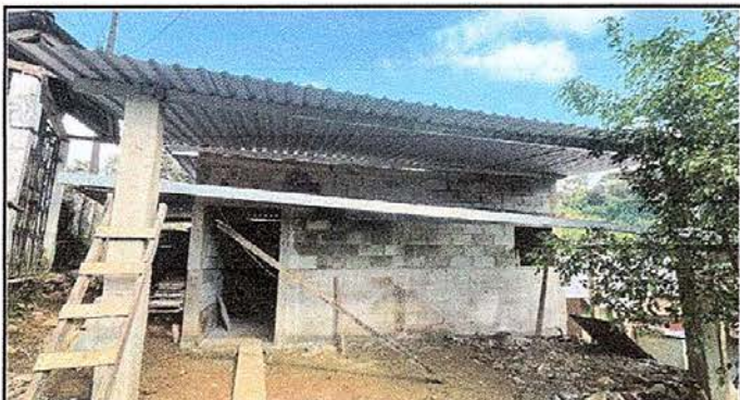
Foto 9: sustitución de pared de madera por block
