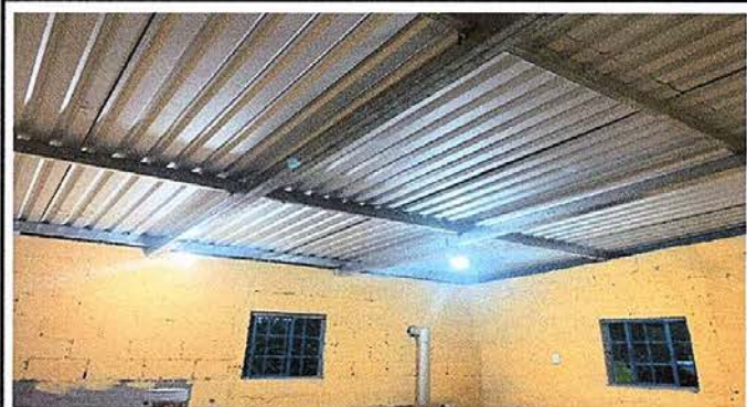
Foto 3: Sustitución de 3 ventanas de madera de 1 metro por 1.20 metros por metal mas vidrio en cocina.
