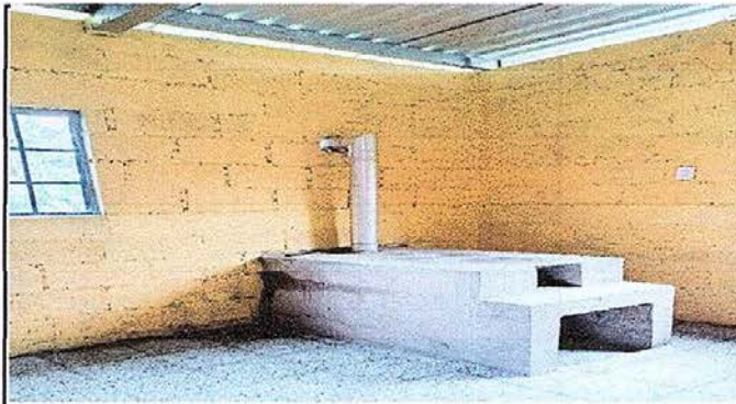
Foto 10: sustitución de estufa rural(completa) incluye chimenea y plancha de metal
