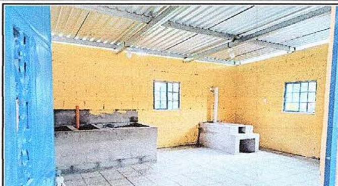
Foto 8: reparación de sistema eléctrico en cocina
