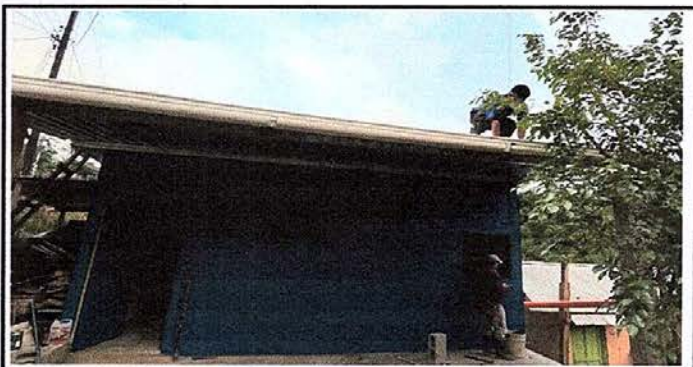
Foto 6: Sustitución de canal de PVC y soporte o pescante.
