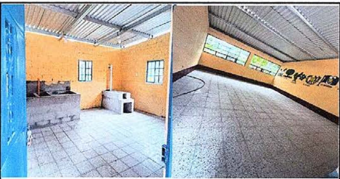
Foto 5: sustitución de piso de granito en cocina y 2 aulas.
