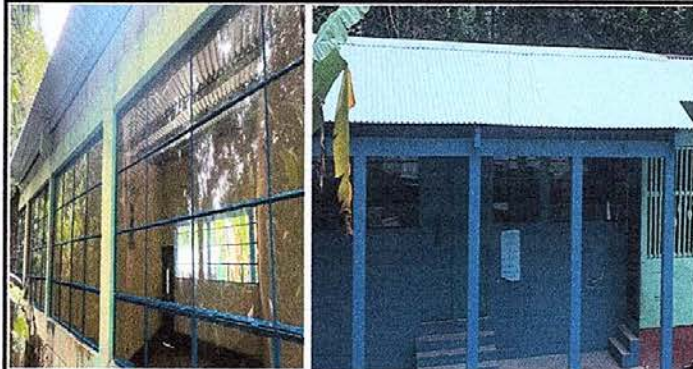
Foto 4: Sustitución de 6 ventanas metálicas de ancho 2.78 mts por alto 1.22 mts y 2 ventanas de ancho 1.68 mts por alto 1.22 mts en la parte de enfrente y atrás de 2 aulas.
