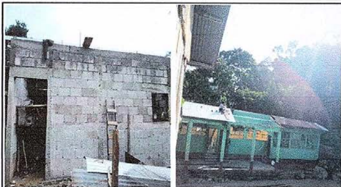
Foto 1: sustitución de lámina, por lámina troquelada aluzinc calibre 26, sustitución de capote, soporte de madera por metal y elementos de fijación en cocina y 2 aulas.
