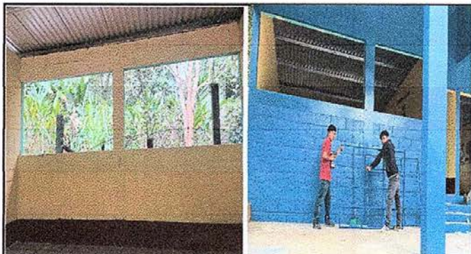
Foto 4: Sustitución de 6 ventanas metálicas de ancho 2.78 mts por alto 1.22 mts y 2 ventanas de ancho 1.68 mts por alto 1.22 mts en la parte de enfrente y atrás de 2 aulas.
