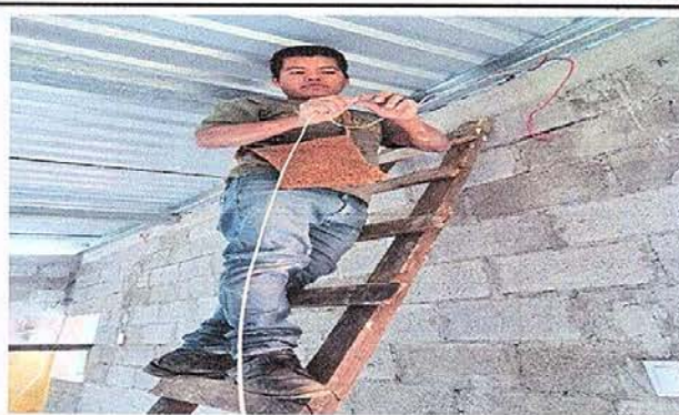
Foto 8: reparación de sistema eléctrico en cocina
