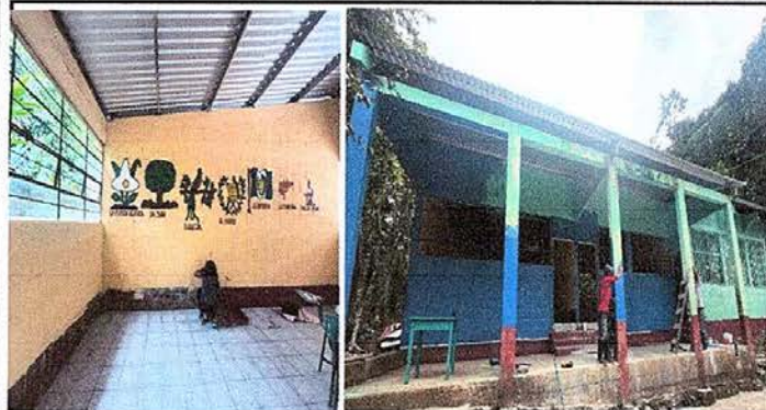
Foto7: aplicación de pintura en paredes exteriores e interiores.
