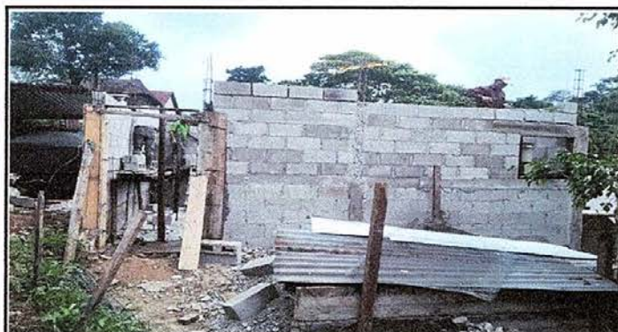
Foto 9: Sustitución de pared de madera por block
