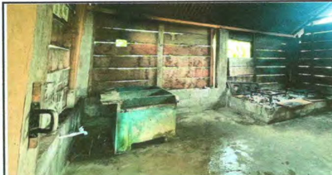
Foto 12: Sustitución de pila de cemento de dos lavaderos.
