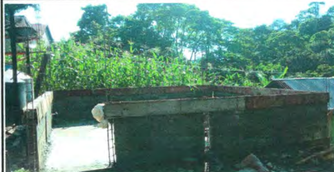
Foto 2: paredes de la cocina con 5 hiladas de block y la solera terminada.
