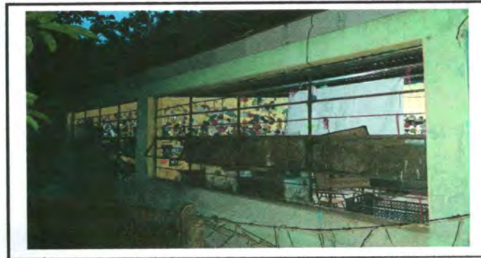
Foto 6: Sustitución de 4 estructuras de metal de ventanas de 1.20 metros por 2.80 metros de 2 aulas de la parte de atrás. Sustitución de vidrios de ambos lados de las 2 aulas.
