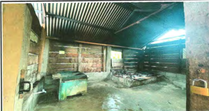
Foto1: sustitución de pared de tabla por block en cocina y reparación de sistema eléctrico.
