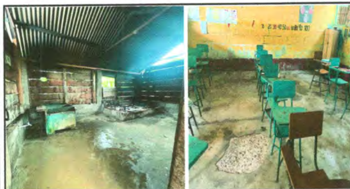
Foto 9: sustitución de piso de granito en cocina y 2 aulas.
