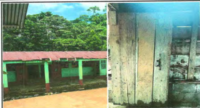
Foto 7: sustitución de puertas de 2 metros por 1.60 metros de tres aulas y de una cocina que ya cumple con las 5 hiladas de block y solera que se observa en la foto anterior.
