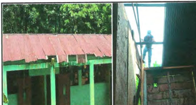
Foto 3: sustitución de estructura de soporte de madera, por metal Sustitución de láminas, por láminas troquelada, aluzinc calibre 26, sustitución de capotes de lámina para lámina troquelada
