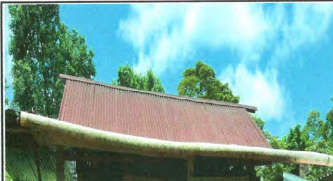
Foto 10: canales y bajadas de agua pluvial.
