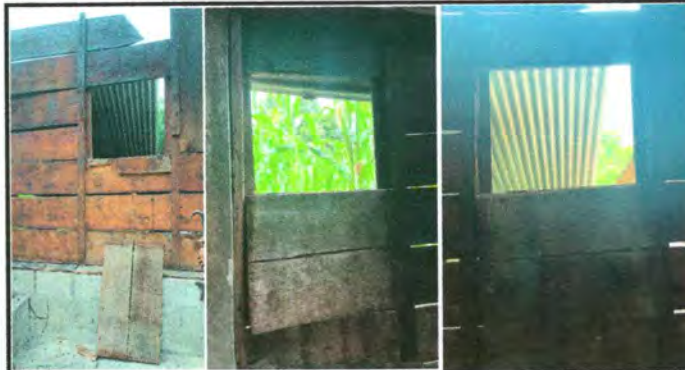
Foto 4: Sustitución de 3 ventanas de madera de 1 metro por 1.20 metros por metal mas vidrio.
