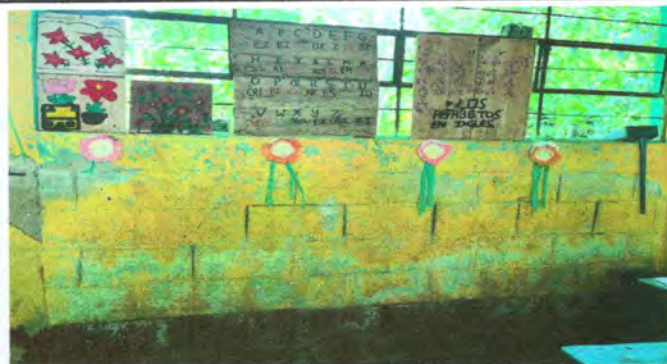
Foto 8: aplicación de pintura en paredes exteriores e interiores.
