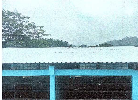
Foto 6: Sustitución de capotes
