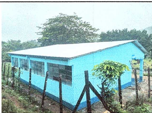
Foto1: Sustitución de techo
