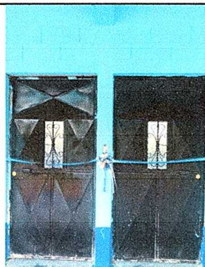
Foto 2: Sustitución de puerta
