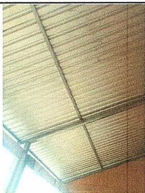
Foto 3: Sustitución de costaneras
