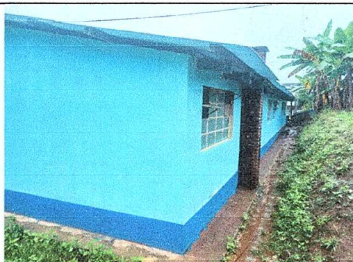
Foto 4: Aplicación de pintura exterior
