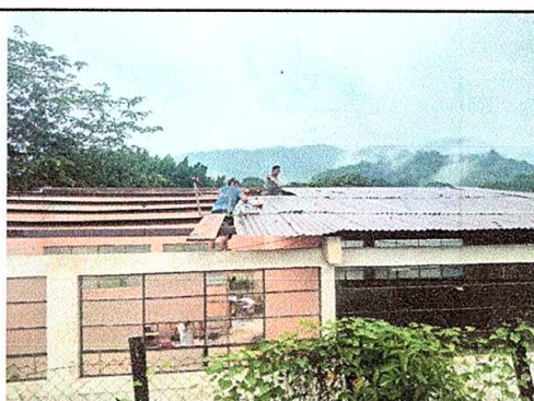
Foto 6: Sustitución de capotes
