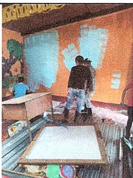
Foto 5: Aplicación de pintura interior
