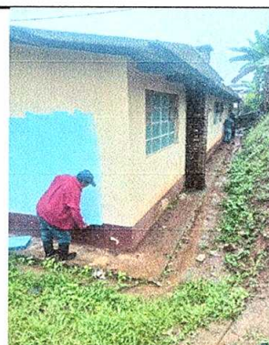
Foto 4: Aplicación de pintura exterior
