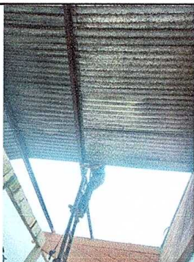
Foto 3: Sustitución de costaneras
