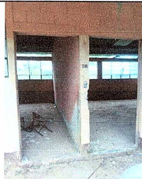
Foto 2: Sustitución de puerta
