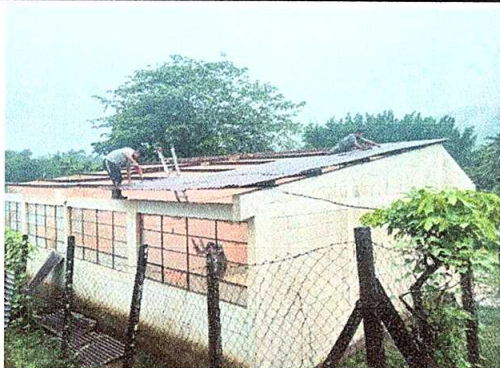
Foto1: Sustitución de techo
