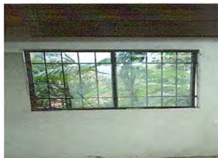
Foto 10: Sustitución de ventana de madera por metal más vidrio (dirección)
