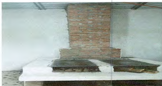
Foto 11: Reparación de cocina completa
