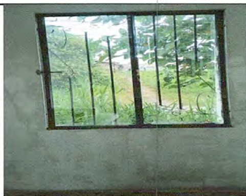
Foto 9: Sustitución de ventana de madera por metal más vidrio (cocina)
