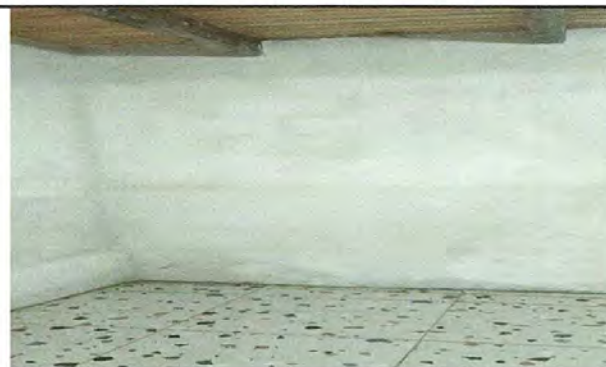
Foto 6: Repello y Reparación de muro perimetral de block (dirección)
