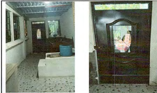
Foto 7: Sustitución de puertas (cocina)
