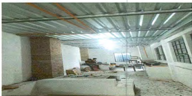
Foto 1: Sustitución de lámina y estructura de madera por metal (cocina)
