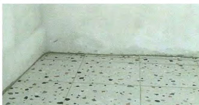
Foto 4: Sustitución de piso de torta de concreto por piso cerámico (dirección)
