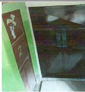
Foto 8: Sustitución de puertas (dirección y aula)
