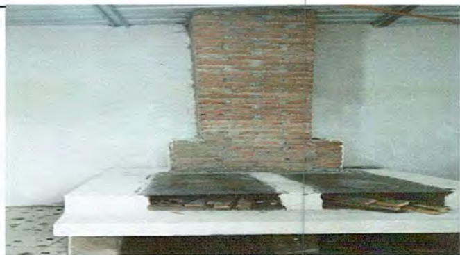
Foto 5: Repello y Reparación de muro perimetral de block (cocina)
