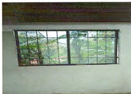
Foto 10: Sustitución de ventana de madera por metal más vidrio (dirección)
