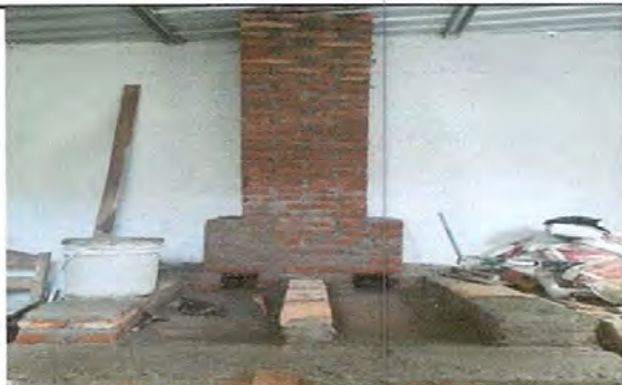
Foto 11: Reparación de cocina completa
