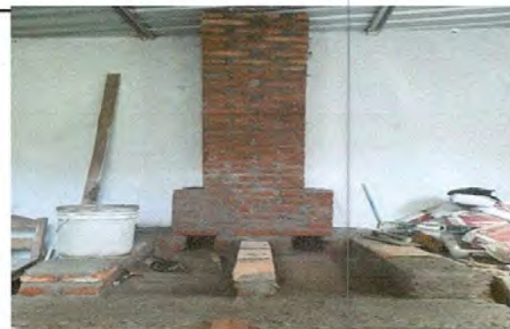
Foto 5: Repello y Reparación de muro perimetral de block (cocina)
