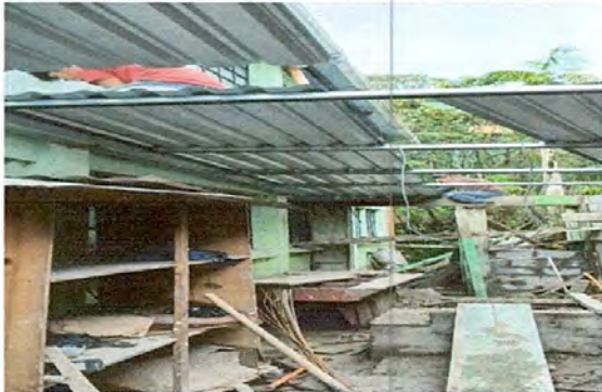
Foto 1: Sustitución de lámina y estructura de madera por metal (cocina)
