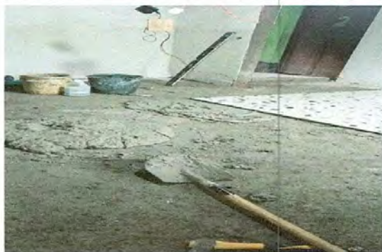
Foto 3: Sustitución de piso de torta de concreto por piso cerámico (cocina)
