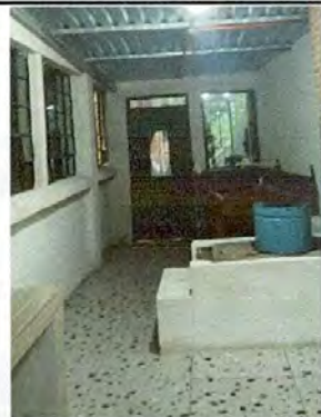
Foto 7: Sustitución de puertas (cocina)
