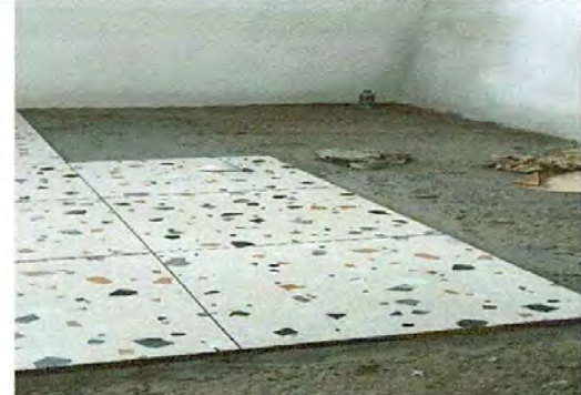
Foto 4: Sustitución de piso de torta de concreto por piso cerámico (dirección)
